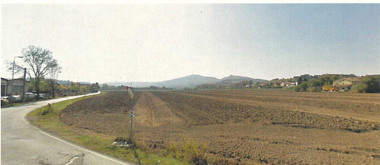
L'area della cassa di laminazione delle piene che rimane seminativo contornata da dune di contenimento delle acque.
