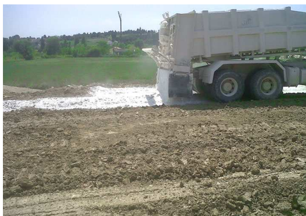
Figura 10.1- Esempio di stesa di ossido di calcio tradizionale Figura 10.2- Esempio di stesa di UNIROAD SPTM
