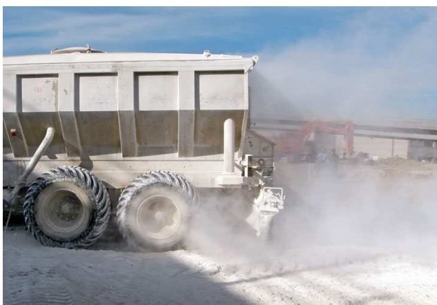
Figura 10.1- Esempio di stesa di ossido di calcio tradizionale Figura 10.2- Esempio di stesa di UNIROAD SPTM
