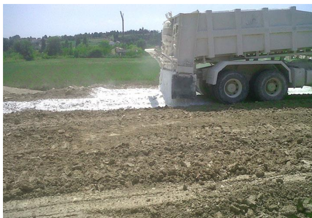
Figura 4.2- Esempio di stesa di UNIROAD SPTM
