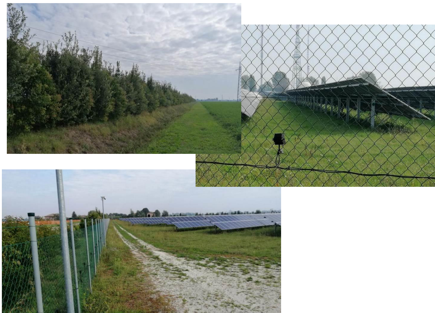
Figura 3.4.1 – Esempio di realizzazione di un impianto fotovoltaico senza fondazioni in cls e senza impermeabilizzazione del suolo (come previsto anche nel caso dell'impianto in esame).
