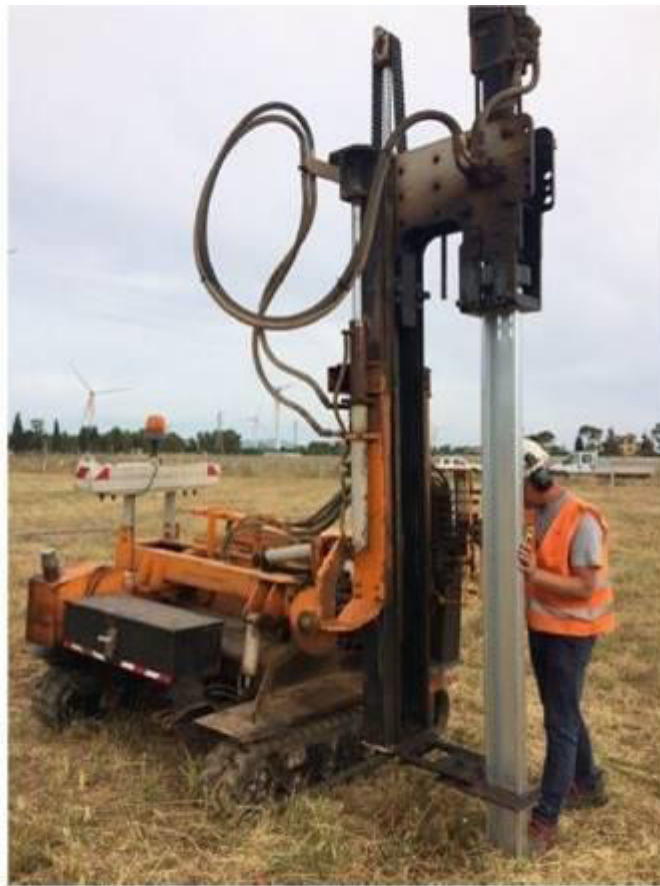
Figura 2.1.1 – Esempio di supporto costituito da palo in acciaio infisso direttamente nel terreno mediante battipalo.
