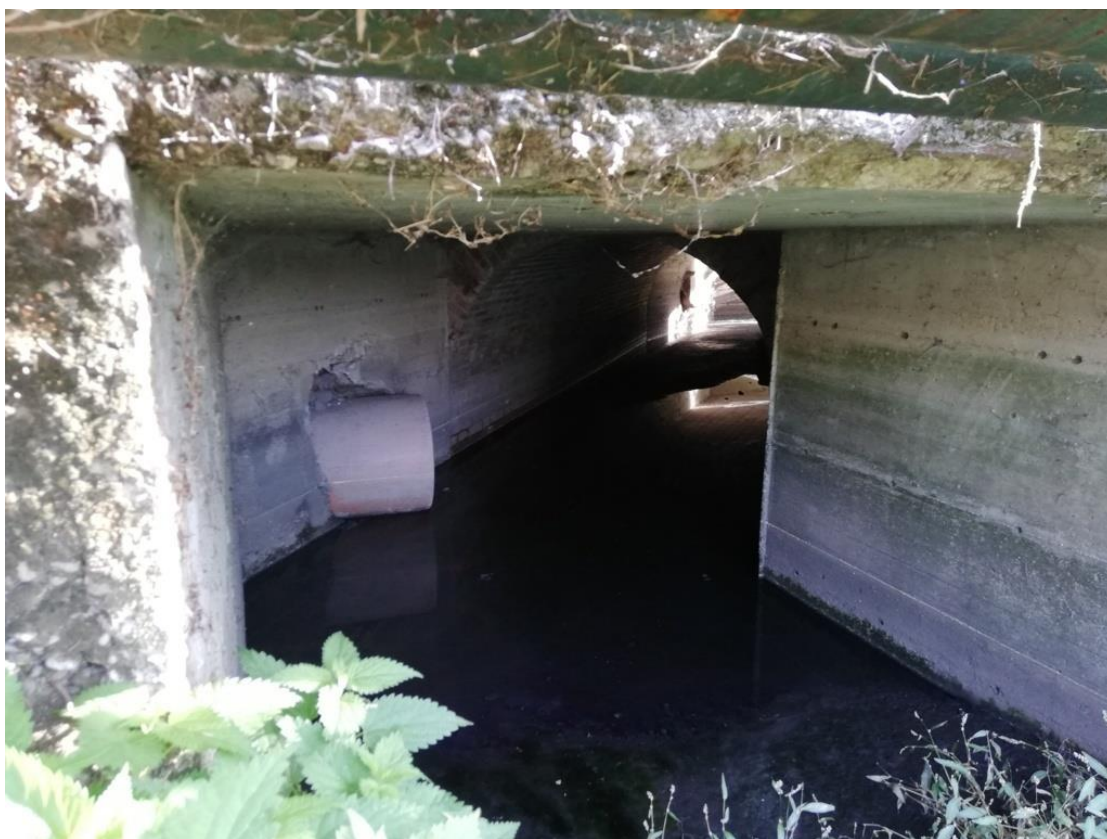
Figura 9: Particolare scatolare del tombamento del canale del Consorzio di Bonifica.
