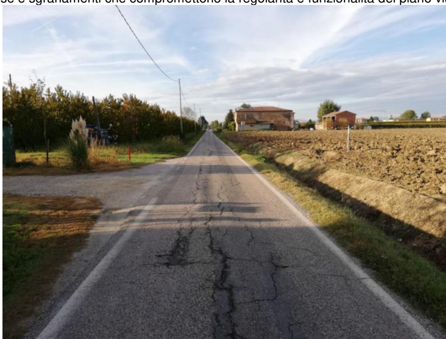
Figura 8: Fessurazioni superficiali della pavimentazione stradale su via Lunga.
