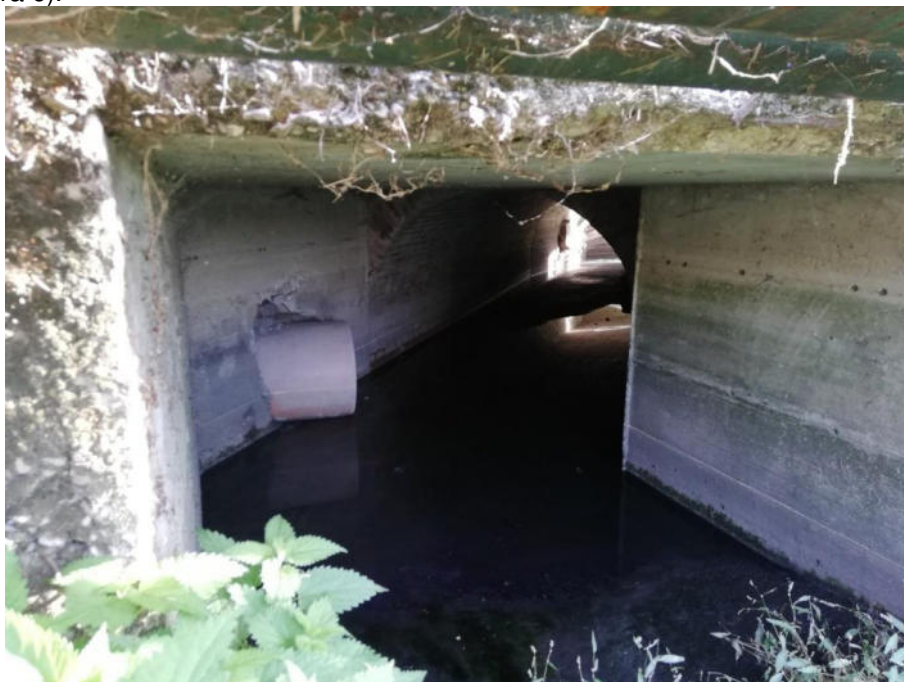
Figura 6: Tombamento del canale del consorzio di bonifica.
