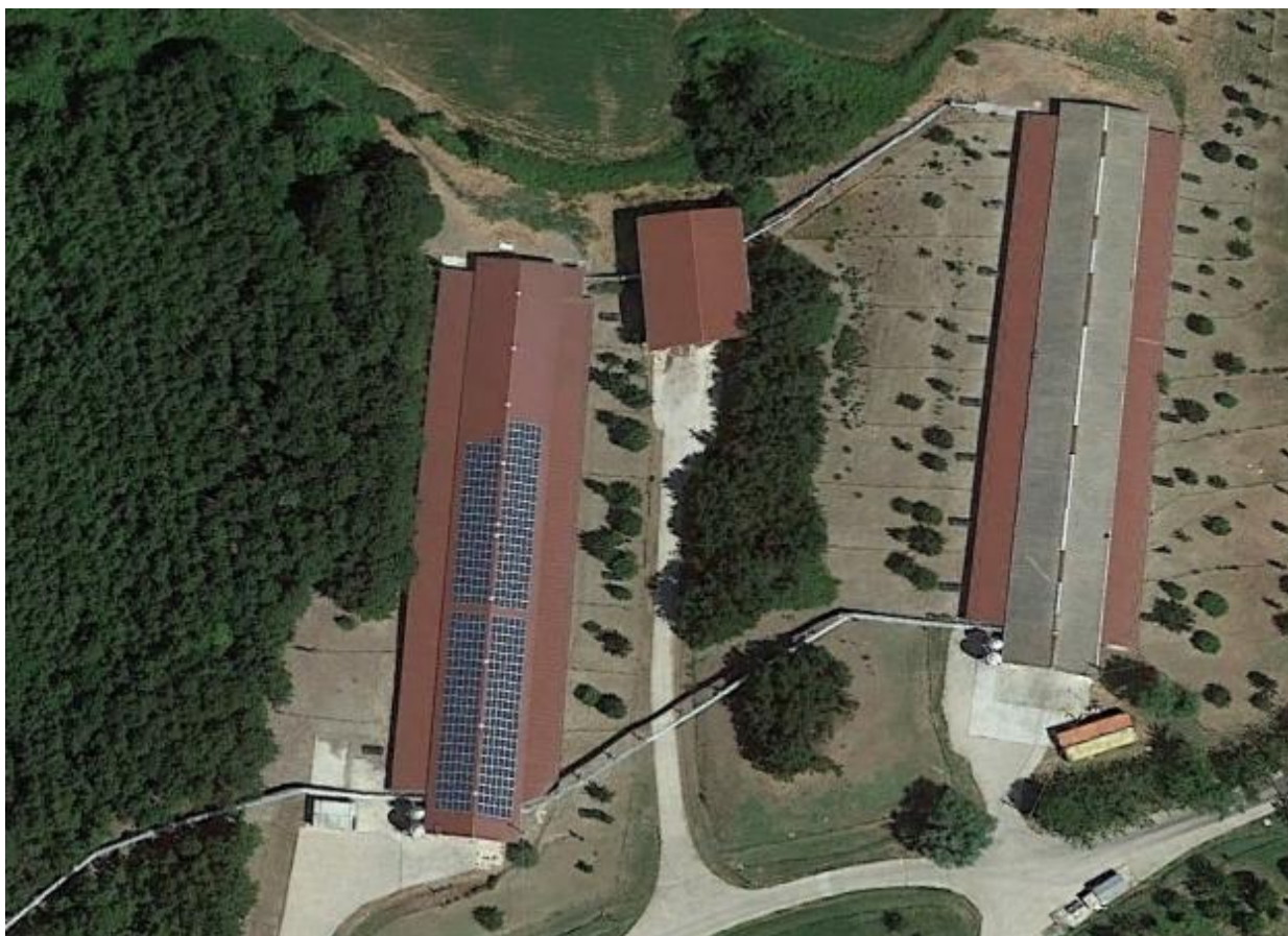
Copertura capannone 4 (Casa 2) con fotovoltaico
