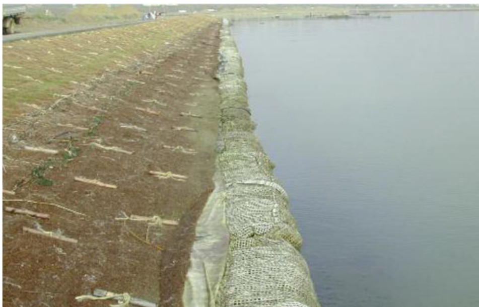
Fig.16 – Schema ed esempio di intervento composto da moduli di materasso-burghe e successivo riempimento e finitura con biostuoia.
