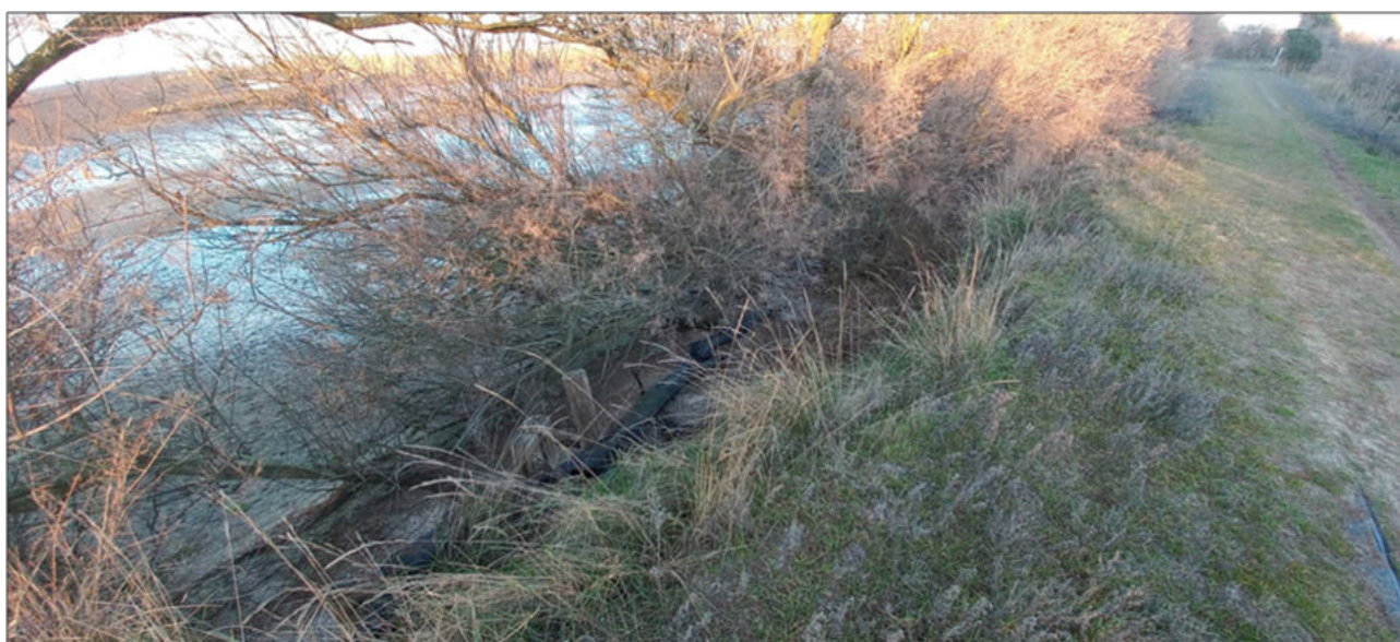
Fig.10 – Particolare dell'argine nord. Si notano i seguenti elementi: disomogeneità della sommità arginale; sponda in dissesto con presenza di precedenti opere rimaneggiate; fondali bassi e dolcemente digradanti prospicienti l'argine.
