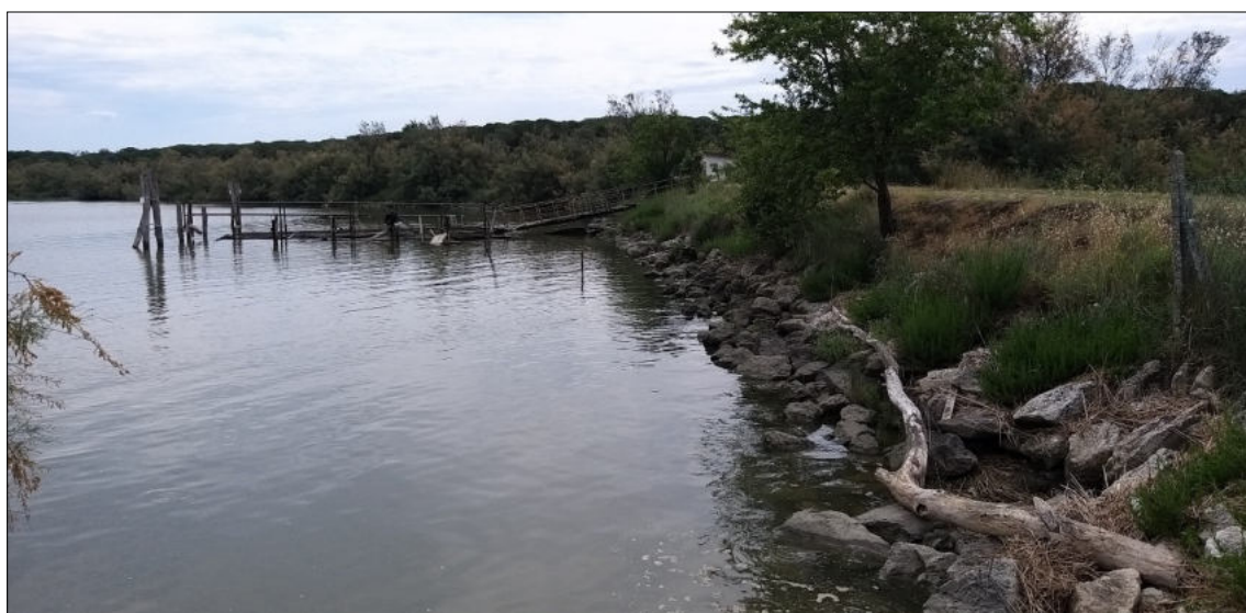
Fig.9 – Argine ovest. Si può stimare lo stato di compromissione del tratto in pietrame che emerge a destra in mezzo alla vegetazione.
