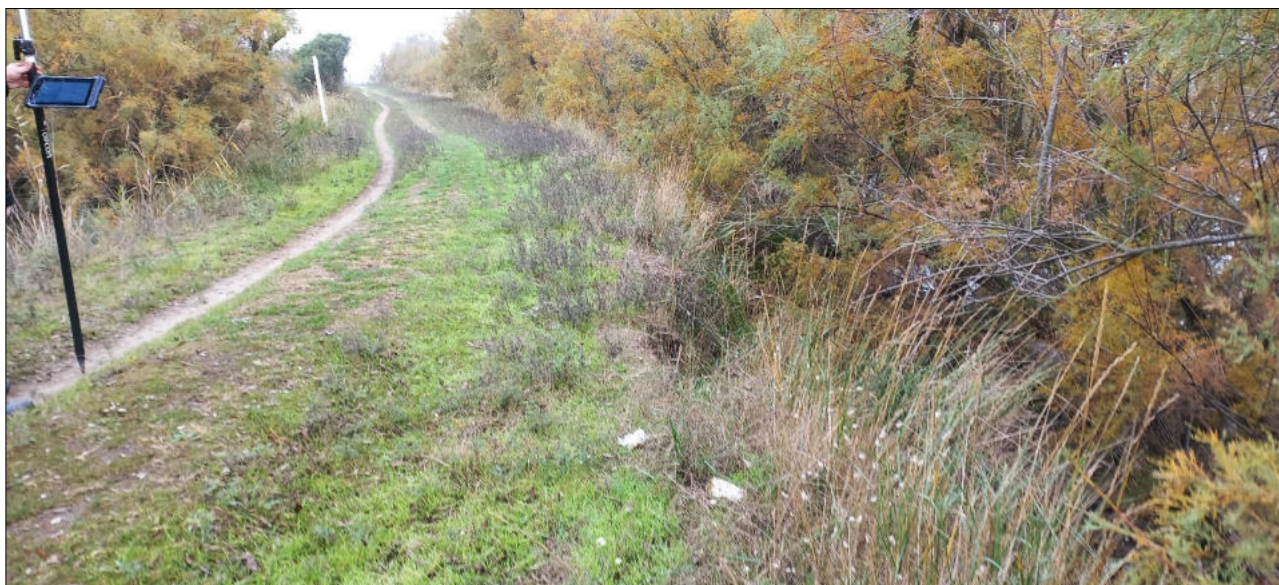
Fig.14 – Sommità arginale interessata dai lavori. Si nota la vegetazione d'alto fusto presente (a destra) e si intuisce l'andamento disomogeneo del tracciato.
