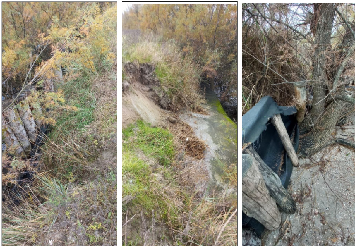
Fig.8 – Particolari dei tratti dell'argine dove sono presenti interventi realizzati in passato con l'inserimento di palificate e geotessuto.
