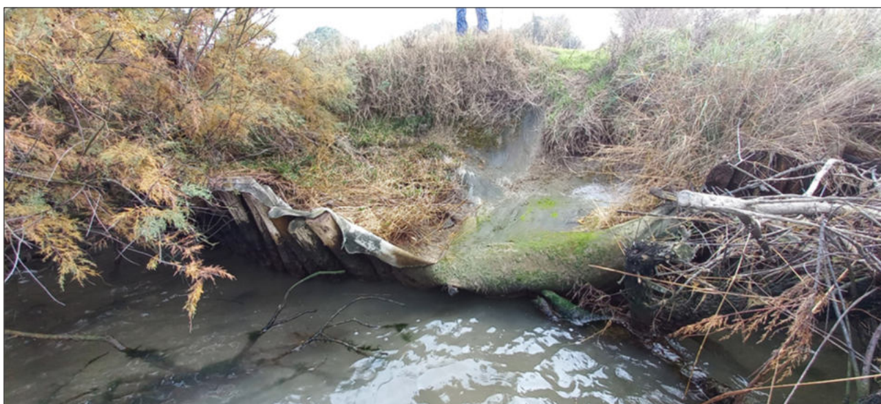
Fig.12 – Particolare di un tratto in dissesto dove sono evidenti gli elementi di un precedente intervento non più funzionali.
