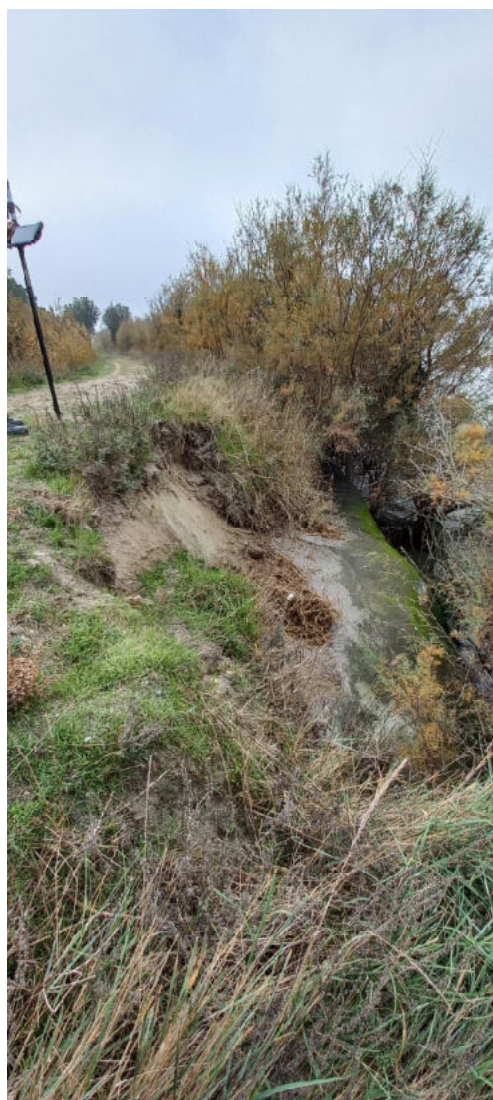
Foto 2 – Particolari dei tratti di argine in dissesto, vista da est verso ovest.
