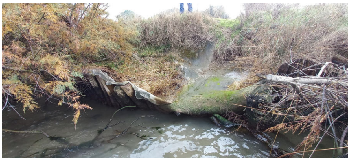
Foto 3 – Tratto in dissesto con compromissione dell'intervento di protezione esistente, vista frontale.
