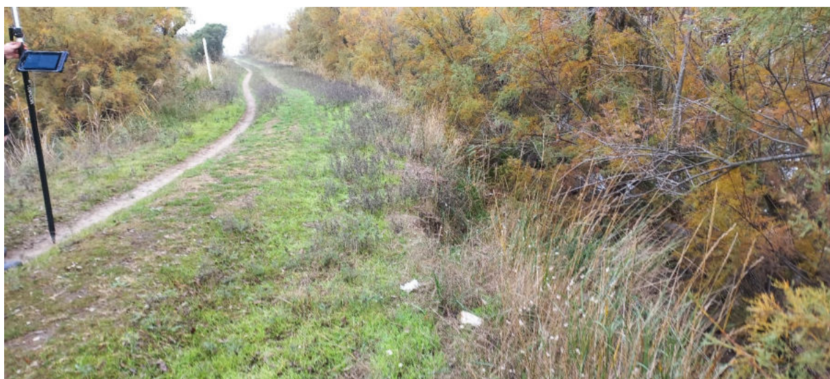
Foto 4 – Particolare della sommità arginale con variabilità della quota massima, vista da est verso ovest.
