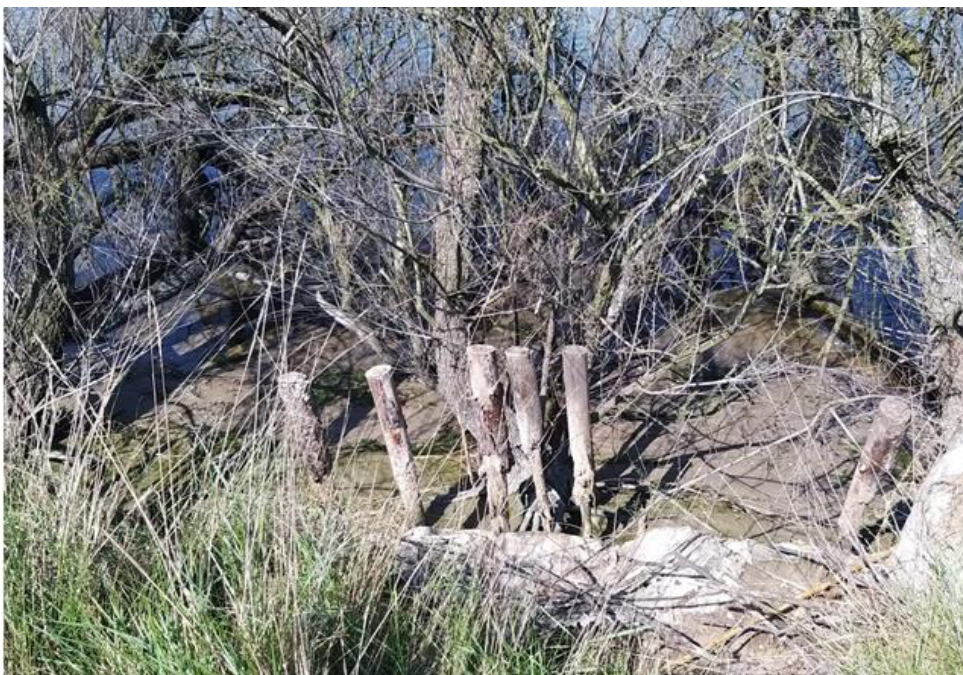
Interventi antierosivi non più efficaci (palizzata il legname di castagno con stuoie)
