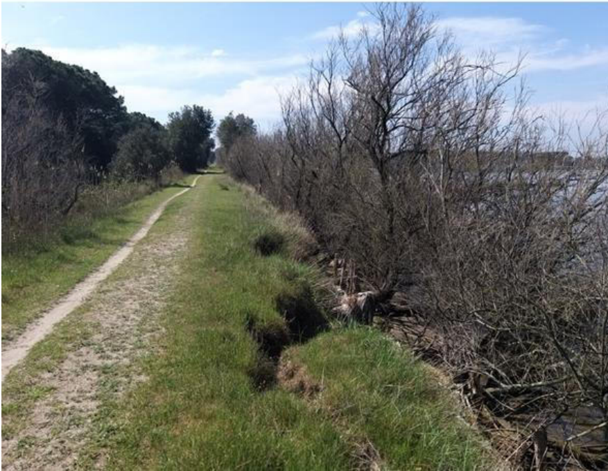
Tratto di argine con evidenti fenomeni erosivi in posizione 3 direzione est-ovest
