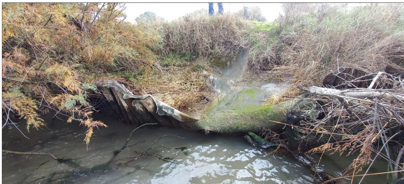
Figura 3.1 – Particolare di un tratto in dissesto dove sono evidenti gli elementi di un precedente intervento non più funzionali.
