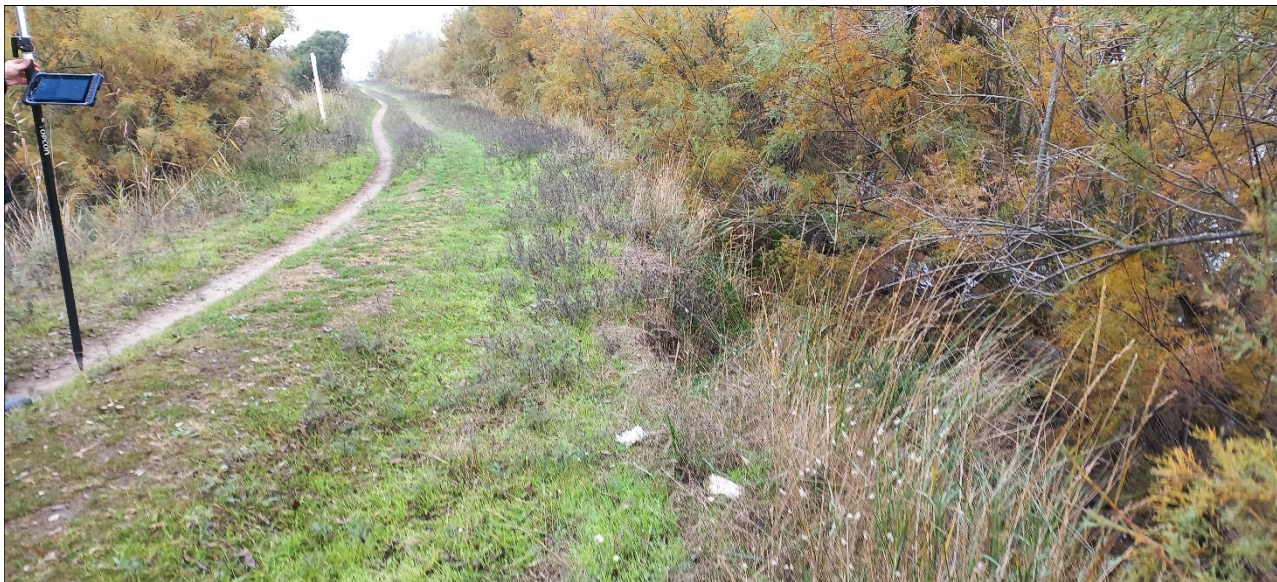
Figura 3.5– Sommità arginale interessata dai lavori. Si nota la vegetazione d'alto fusto presente (a destra) e si intuisce l'andamento disomogeneo del tracciato.
