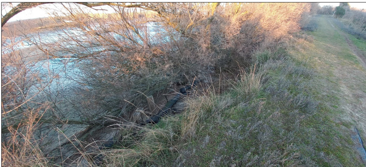
Figura 3.1 – Particolare dell’argine nord. Si notano i seguenti elementi: disomogeneità della sommità arginale; sponda in dissesto con presenza di precedenti opere rimaneggiate; fondali bassi e dolcemente digradanti prospicienti l’argine.
