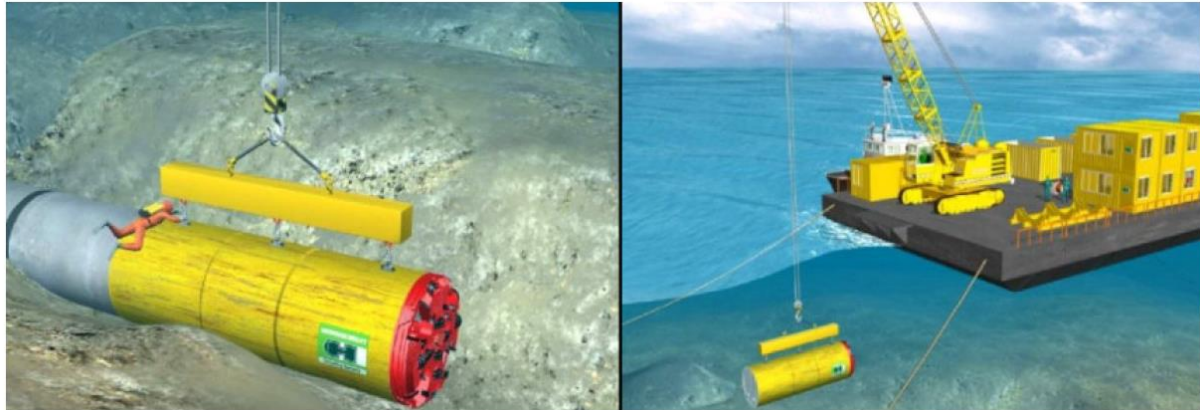
Figura 2-13: Recupero della fresa meccanica a mare
