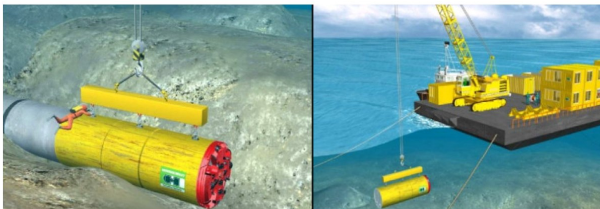
Figura 4.9: Recupero della fresa meccanica a mare
