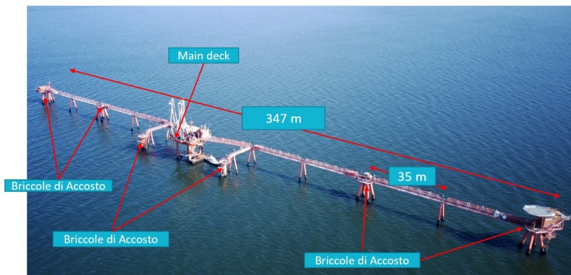
Figura 4.1: Struttura del Piattaforma offshore PETRA esistente
