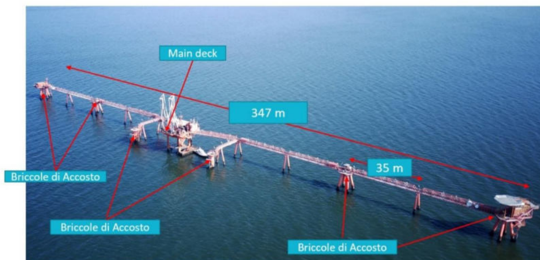
Figura 3.1: Struttura del Piattaforma offshore PETRA esistente
