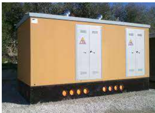
Figura 8: Esempio di cabina C.A.V. La parte nera costituisce la vasca di fondazione e raccolta cavi, che sarà interrata
