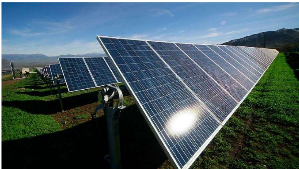
Figura 4: Esempio di tracker monoassiale
