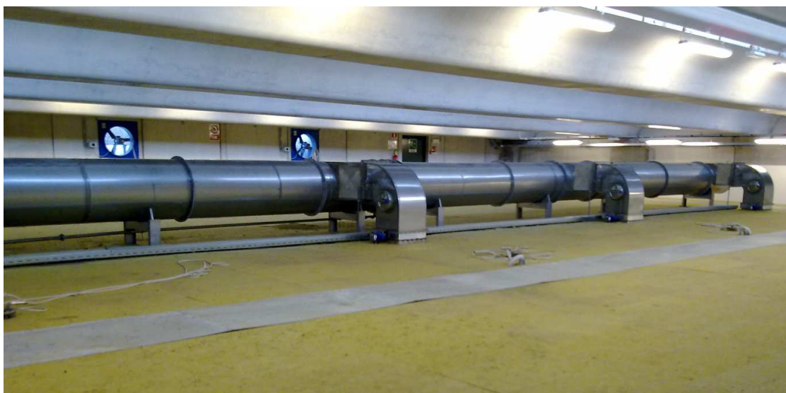
Figura 7-4 – Tipico sistema estrazione aria da biocella
