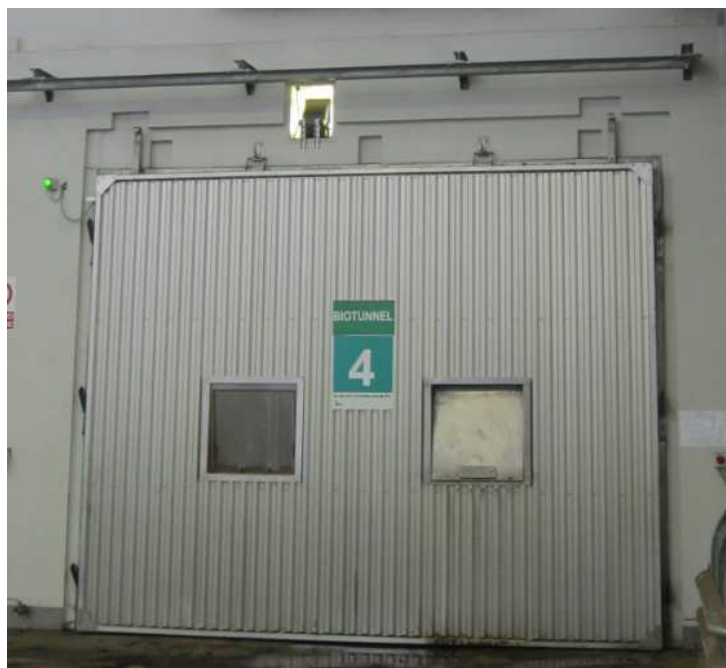
Figura 7-2 – Portone biocella con serrande e guida di movimentazione carrello
