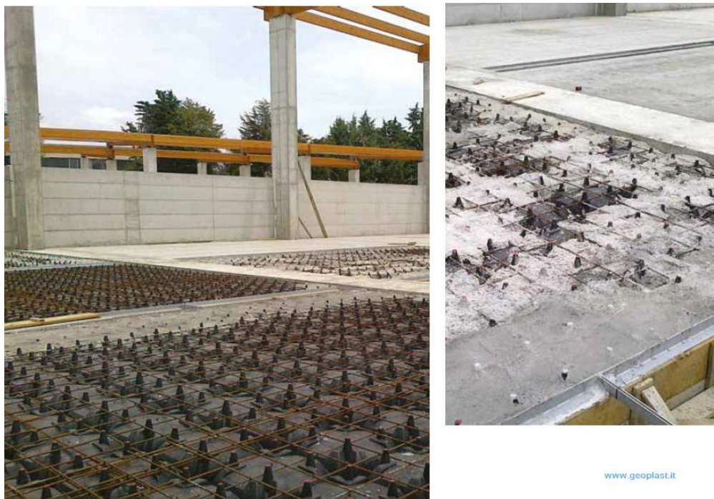
Figura 7-7 – Immagine tipica pavimento aerato in fase di realizzazione
