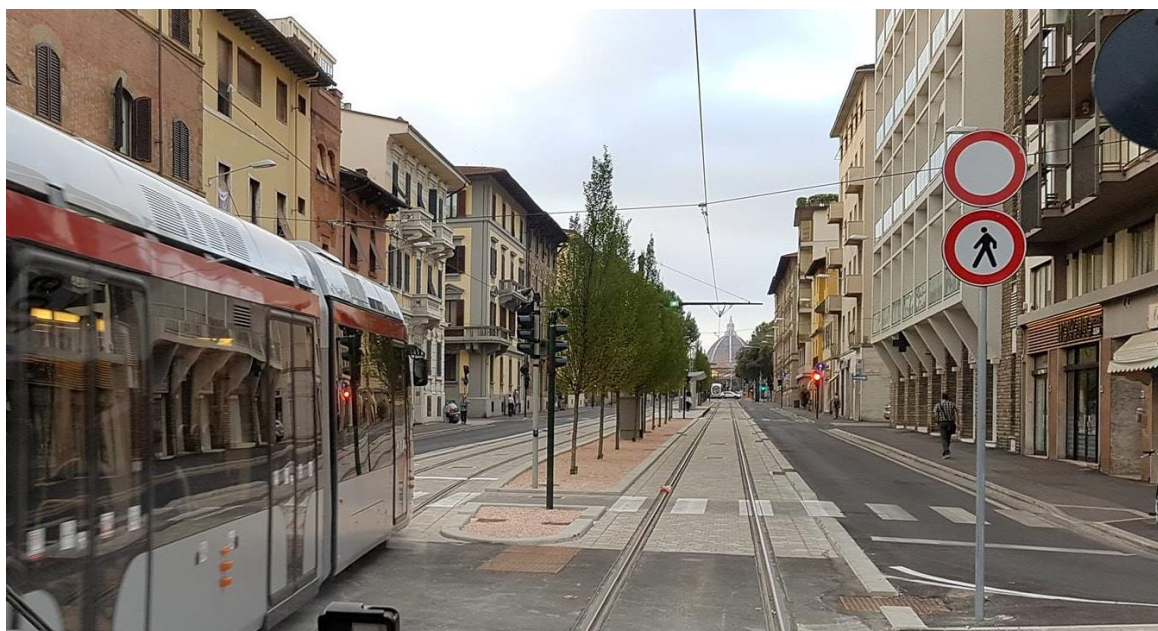
Figura 4. Sede tranviaria riservata con cordolo laterale
