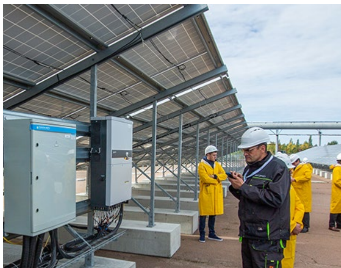
Figura 4 – Inverter statico trifase alloggiati sotto i moduli fotovoltaici
