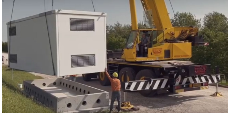
Figura 28: Fornitura e posa in opera delle cabine di campo e dei locali tecnici
