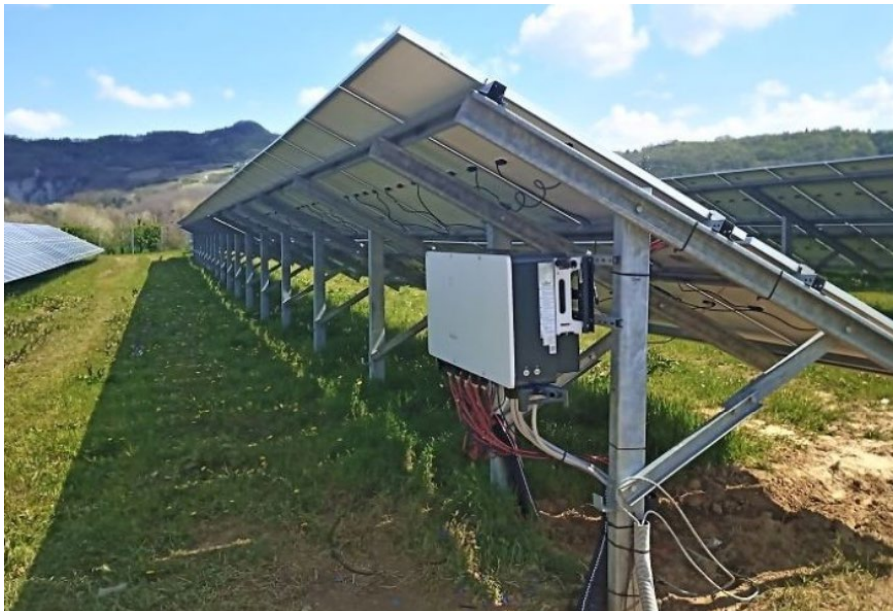
Figura 25: Esempio di cablaggio inverter di stringa
