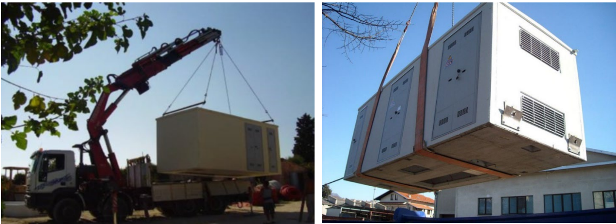
Figura 34: Rimozione delle cabine di raccolta e delle power station
