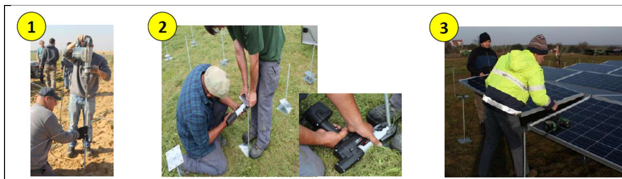
Figura 10 – Montaggio dei pannelli fotovoltaici
