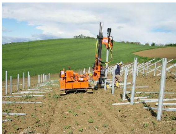
Figura 3: - Posa strutture metalliche di fondazione
