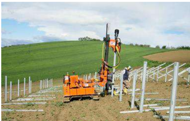
Figura 3.11 – Messa in opera delle strutture di sostegno
