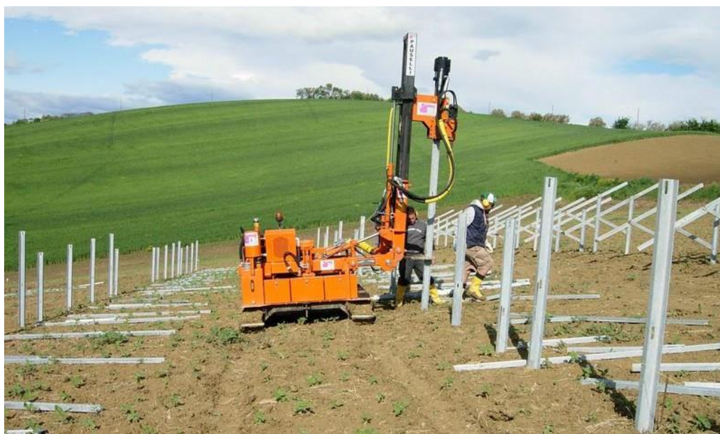
Figura 21 Macchina battipali per l'ancoraggio delle strutture che non richiede opere di scavo
