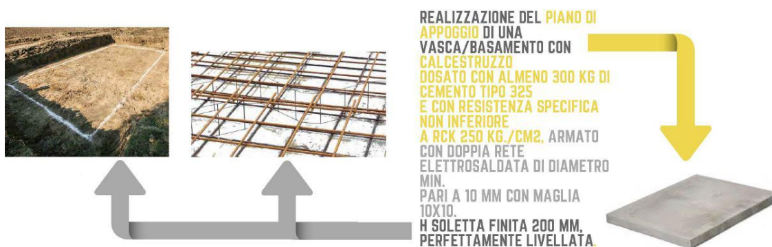
Figura 20 Scavi per la realizzazione del piano di appoggio delle vasche di fondazione delle cabine
