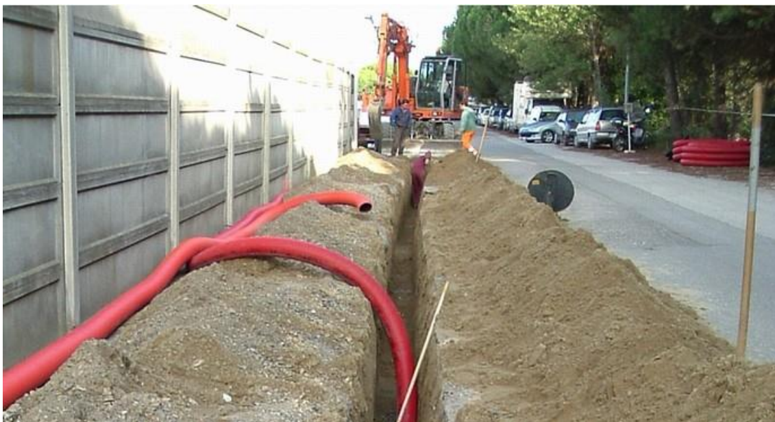
Figura 19 Cantiere per linea elettrica di media tensione interrata su strada asfaltata
