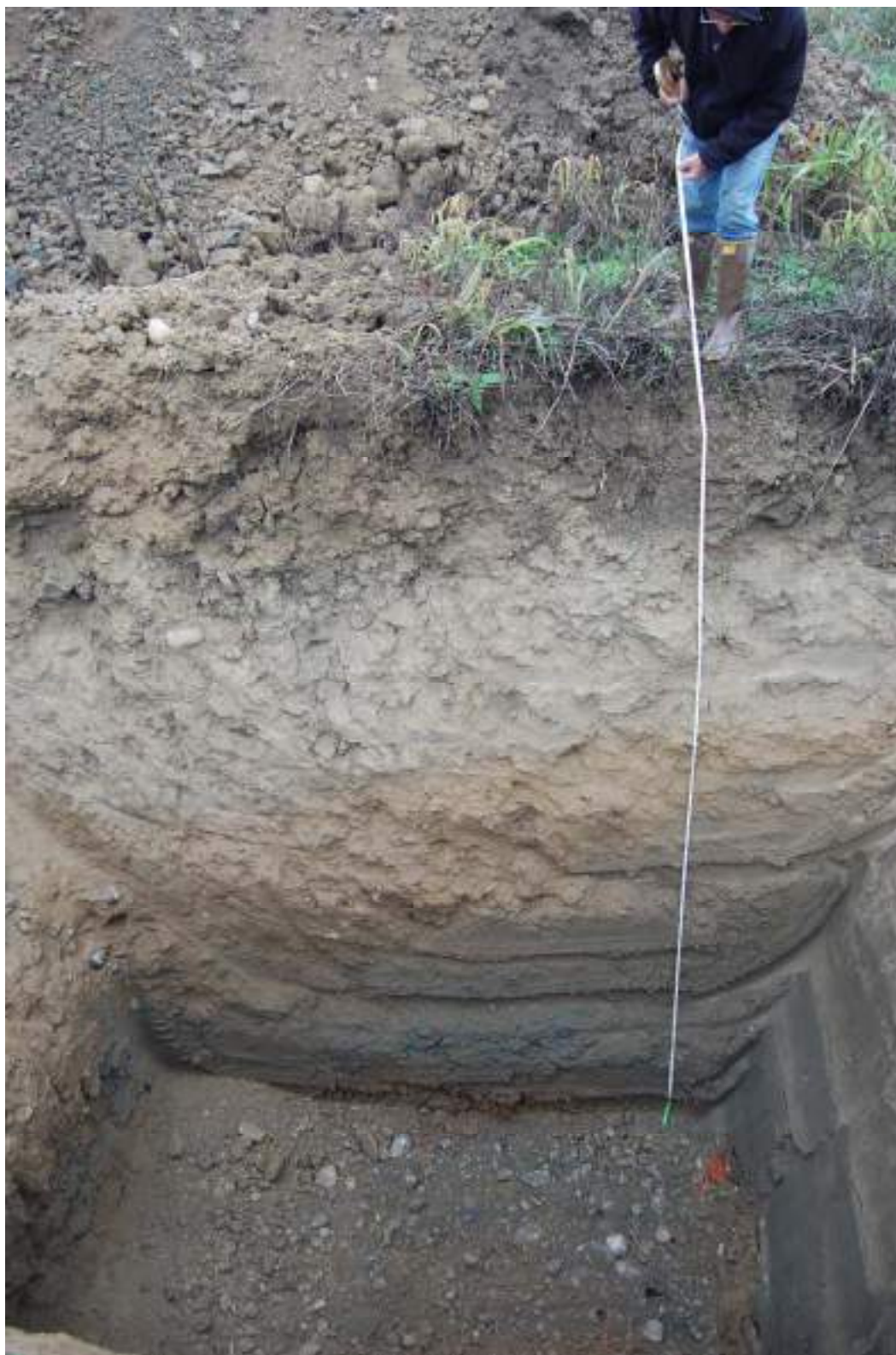
Foto n°1: Il sondaggio a mezzo escavatore idraulico eseguito sull'area "Lampugnana 1"
