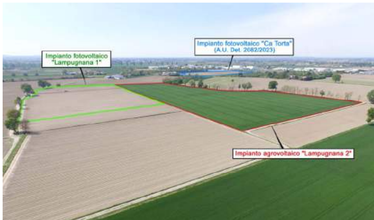
Foto n°4: Individuazione delle aree di intervento da ripresa SAPR
