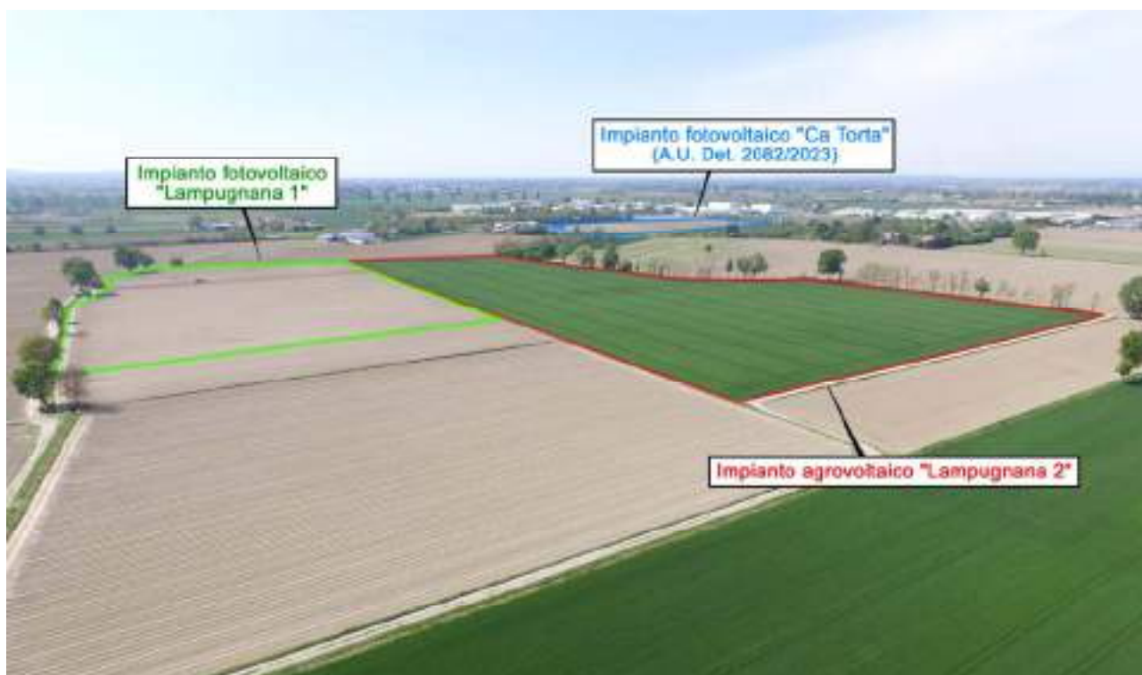
Foto n°1: Panoramica da volo SAPR - ripresa da nord
