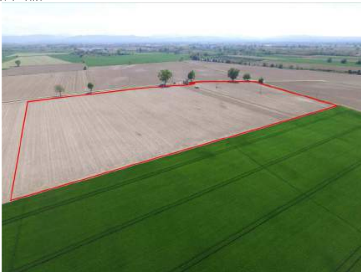
Foto n°3: Panoramica da volo SAPR - ripresa da nord est dell'area ove è prevista la realizzazione dell'impianto fotovoltaico "Lampugnana 1"
