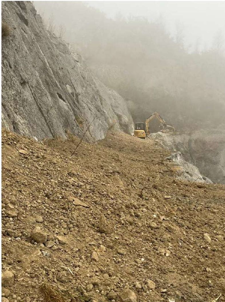
Figura 6-5 Stendimento del terreno vegetale sui gradoni
