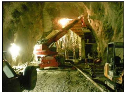
Figura 2-15 Fase di realizzazione della centinatura
