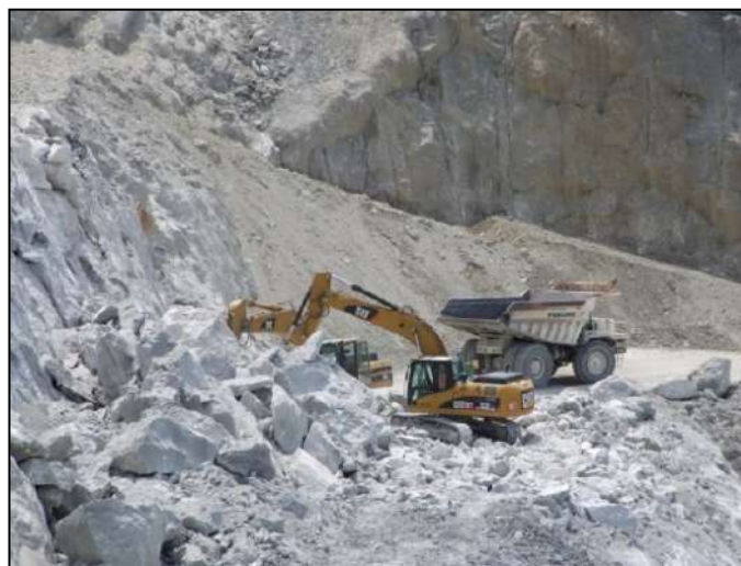
Figura 3-2 Operazioni di smarino
