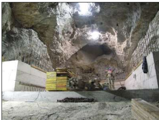
Figura 2-14 Fase di realizzazione della centinatura
