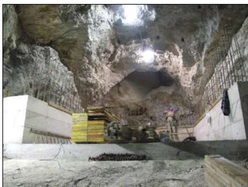
Foto 1: Fase di realizzazione della centinatura
