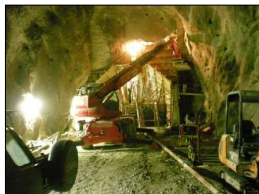
Foto 2: Fase di realizzazione della centinatura
