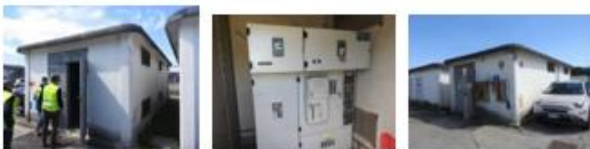
Figura 29 - a) Ingresso Cabina Cessione e Cabina Riserva; b) Quadro MT Generale dentro cabina di cessione; c) Ingresso Cabina Area
