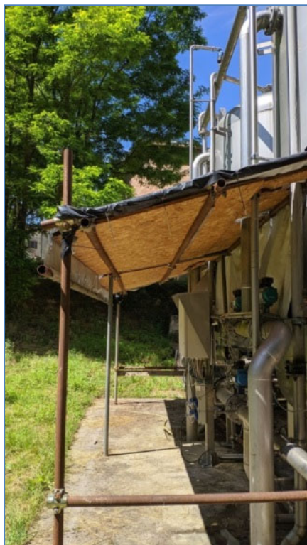
Copertura nell'area filtri, da rifare
