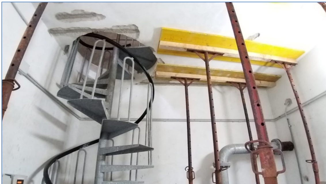
Scala interna da rimuovere e sostituire, solaio da adeguare
