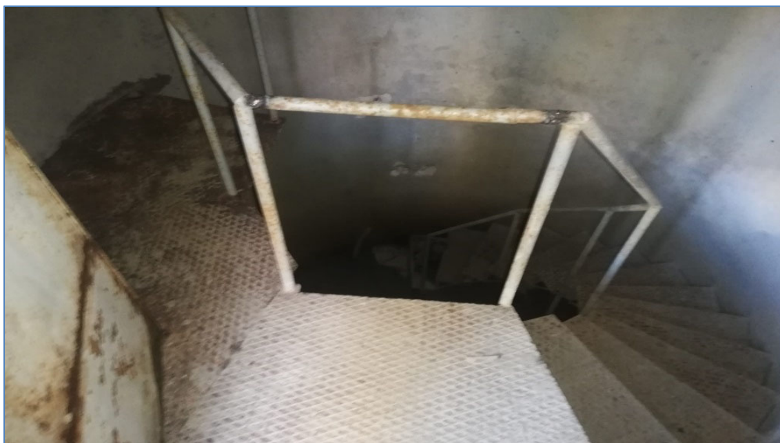
Scale e pianerottolo edificio ingresso galleria drenante, da rifare
