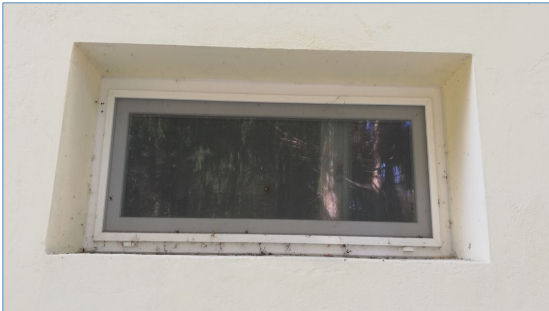
Dettaglio di una finestra, infisso da sostituire
