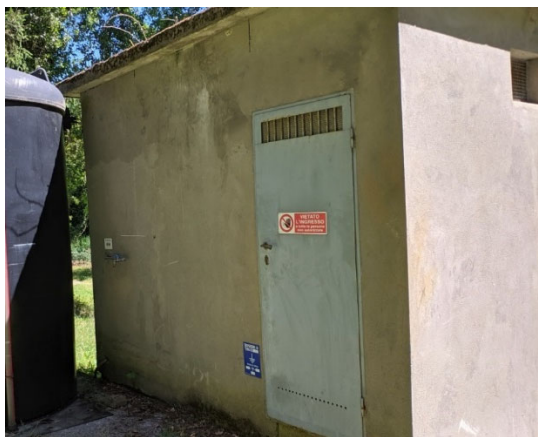
Edificio del pozzo di presa, con porta e finestrino da sostituire
