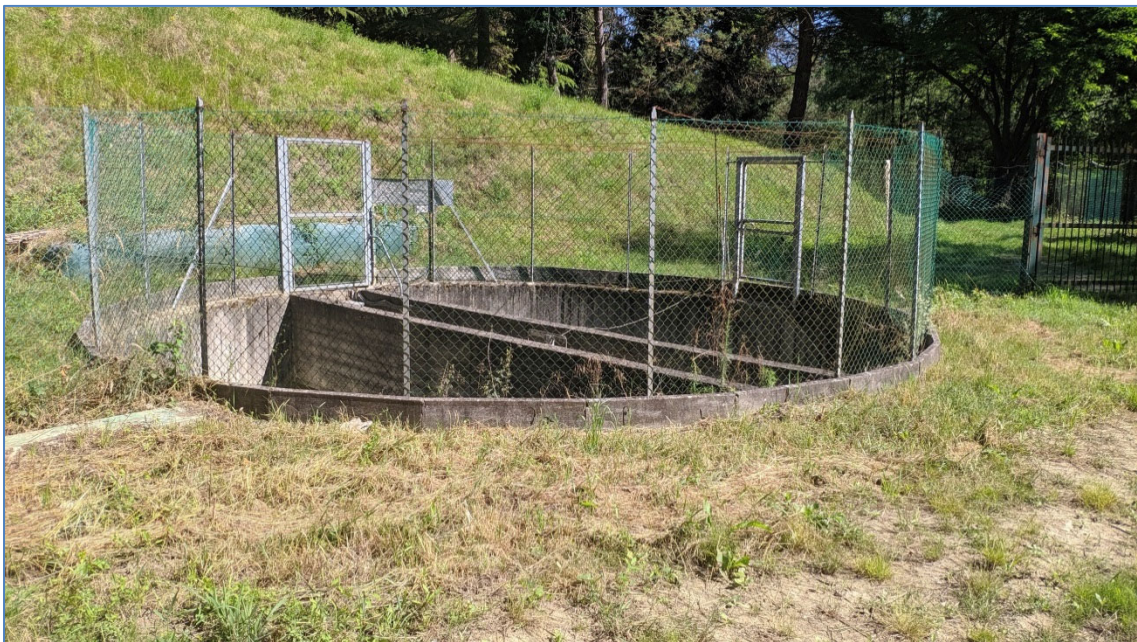
Sedimentatore primario, rete da sostituire e muretto di contenimento da rialzare
