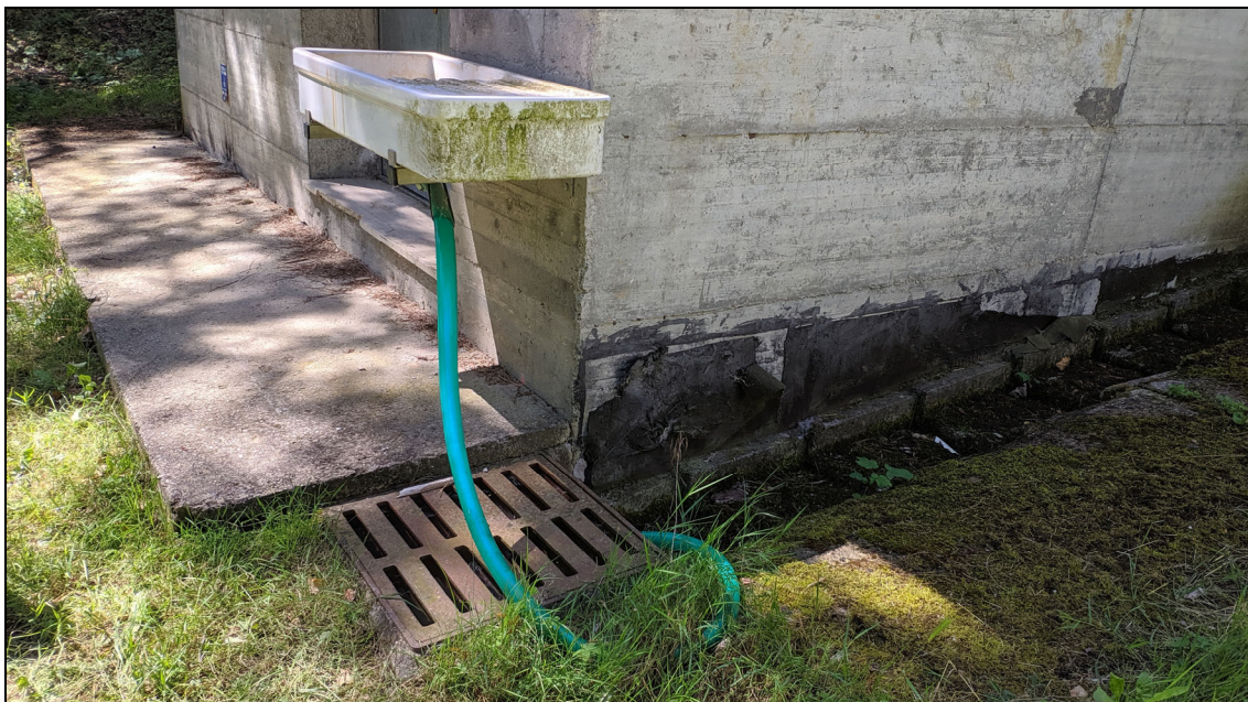
Pozzetto di raccolta delle acque di pioggia, da sostituire e riconnettere con la nuova tubazione interrata
