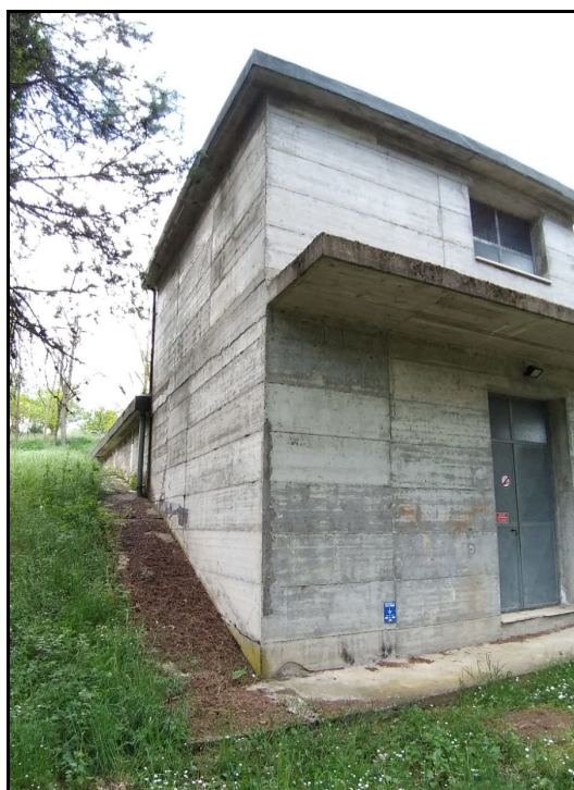
Marciapiede lato SSE formato da lastre di cemento molto deteriorate, da sostituire
