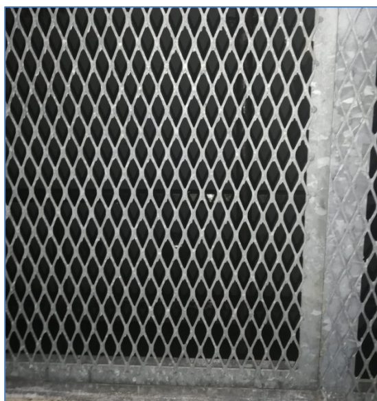
Dettaglio della griglia antianimali, da sostituire insieme a tutto l'infisso
