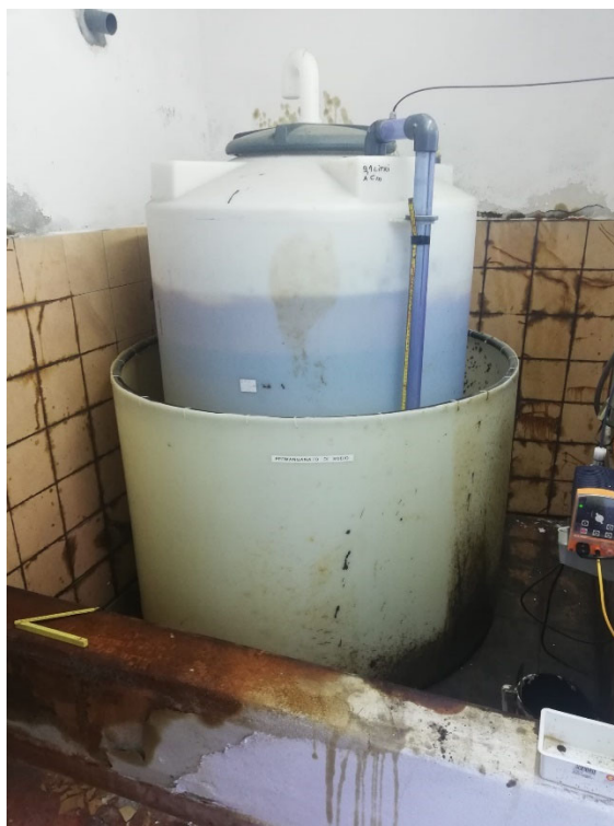
Intonaci e rivestimenti locale permanganato da ripristinare
