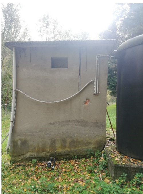
Finestrino e pluviale da sostituire e ripristino guaina impermeabile copertura
