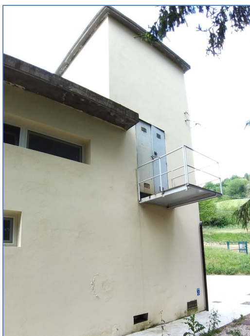
Accesso al primo piano dall'esterno, da integrare con una nuova scala metallica
