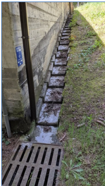
Sistema di drenaggio ad embrici, lato NNE, da sostituire con tubo interrato e marciapiede
