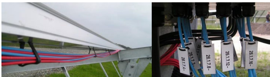
Figura 3: Conduttori DC (lato BT)
