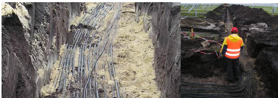
Figura 4: Conduttori CA (lato BT)
