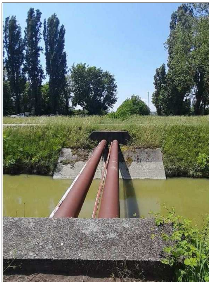
Figura 4.3.1 – Attraversamento del Canal Bianco da parte delle tubazioni esistenti della mandata/arrivo dell'acqua della rete di teleriscaldamento
