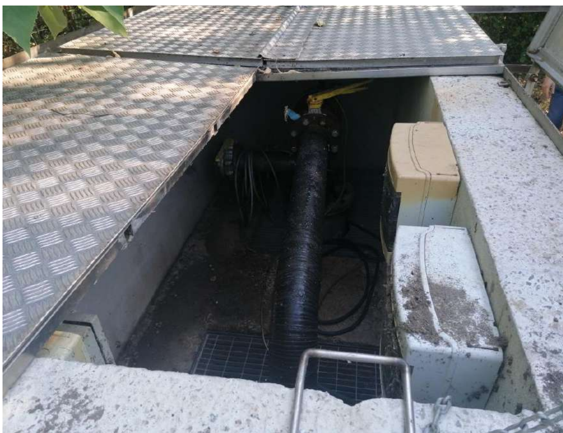
Figura 5-14 Interno del manufatto in c.a. a difesa del pozzo Moretti 1
