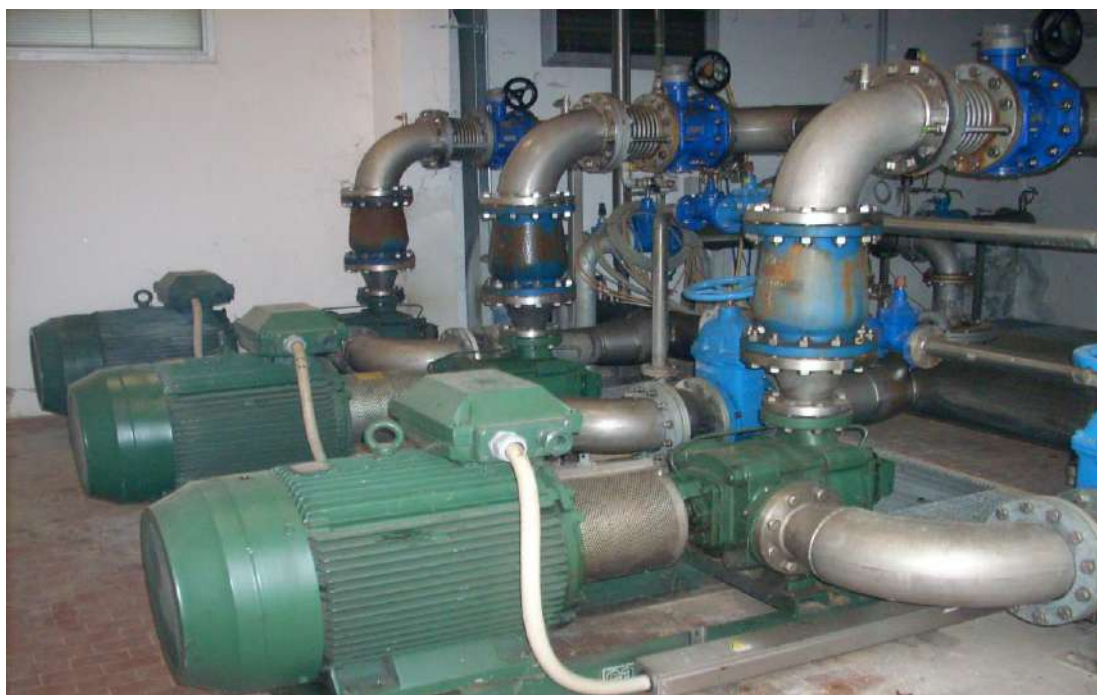
Figura 3-5 Gruppo di pompaggio per il sollevamento delle acque emunte dal campo pozzi verso il serbatoio “La Costa”
