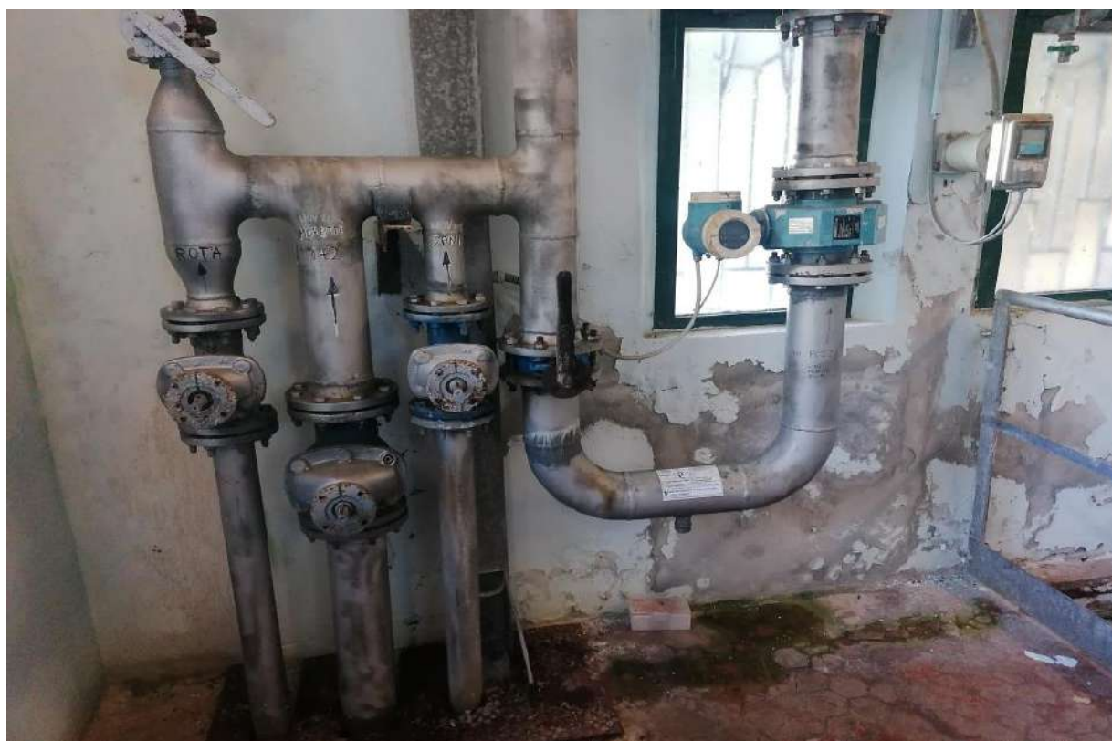
Figura 3-22 Particolare condotte in arrivo dai pozzi Sani, Rota e Moretti 1
