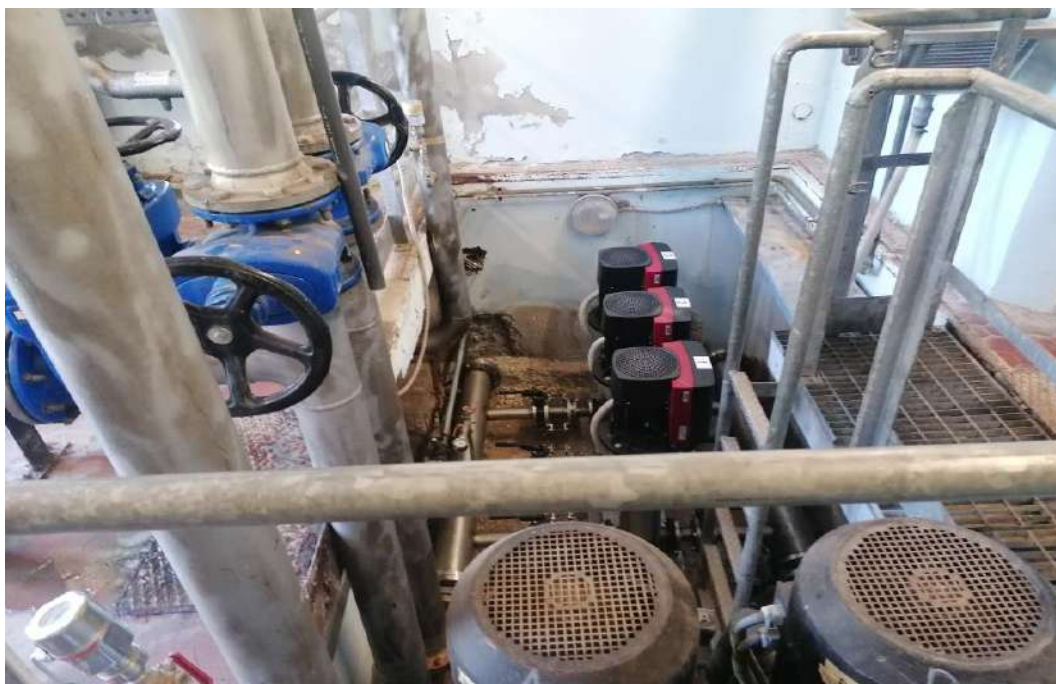
Figura 3-23 Gruppo di pompaggio per il sollevamento delle acque emunte dal campo pozzi verso il serbatoio Guardasone e Vignale-Traversetolo
