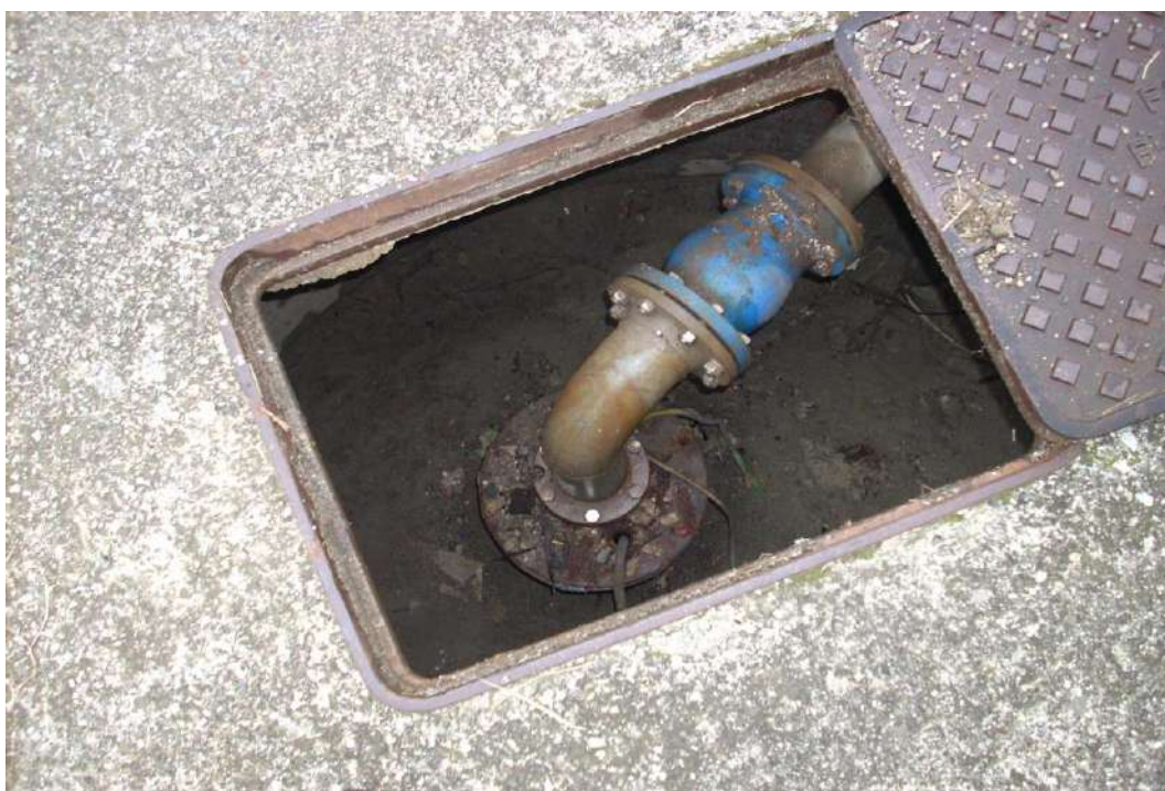
Figura 3-12 Particolare testa pozzo Masdone 1
