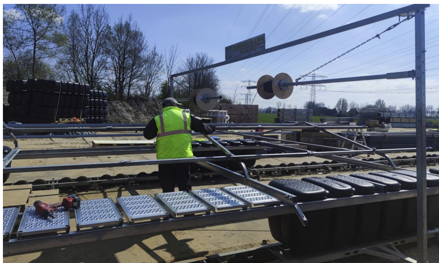
Foto 19 – operazione di assemblaggio dei moduli galleggianti e dei componenti nella zona cantiere.
