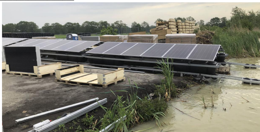
Foto 20 – modulo galleggiante assemblato e pronto per essere spostato in acqua utilizzando il binario/scivolo dalla riva.
