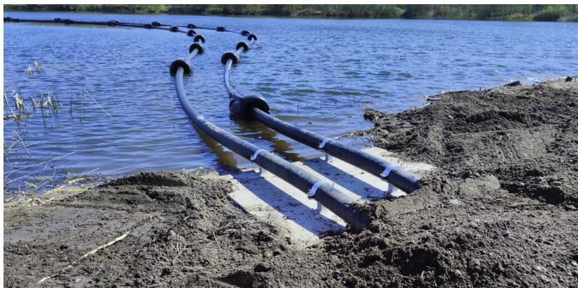
Foto 4 – dettaglio della piattaforma in cls di dimensioni 2x2 metri prefabbricata per l'ancoraggio dei cavi alla sponda. I cavi saranno poi posti in cavidotti interrati fino alla cabina di consegna.
