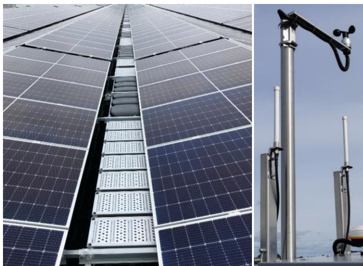
Fig. 12 – sulla sinistra dettaglio dell'area tra i pannelli fotovoltaici utilizzata per l'accesso del personale sopra i moduli galleggianti. A destra sistema di rilevazione dei dati meteo.
