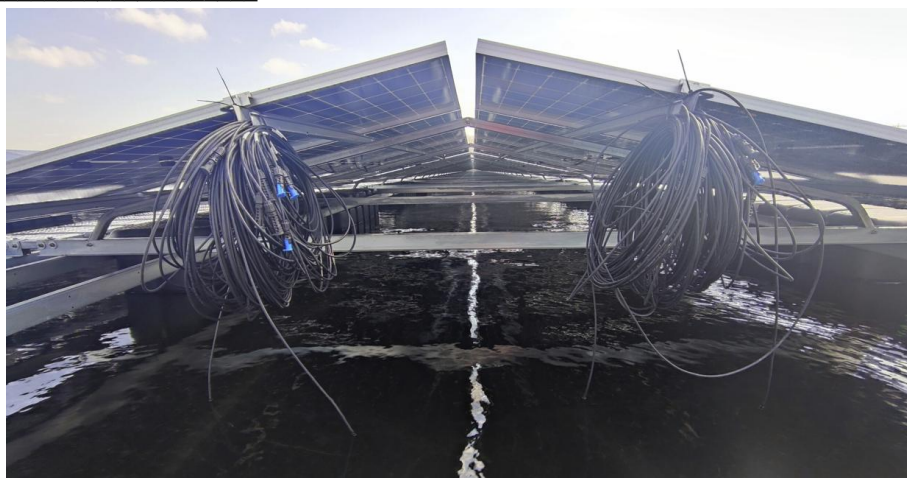
Foto 21 – cablaggi da eseguire sui moduli galleggianti già assemblati.
