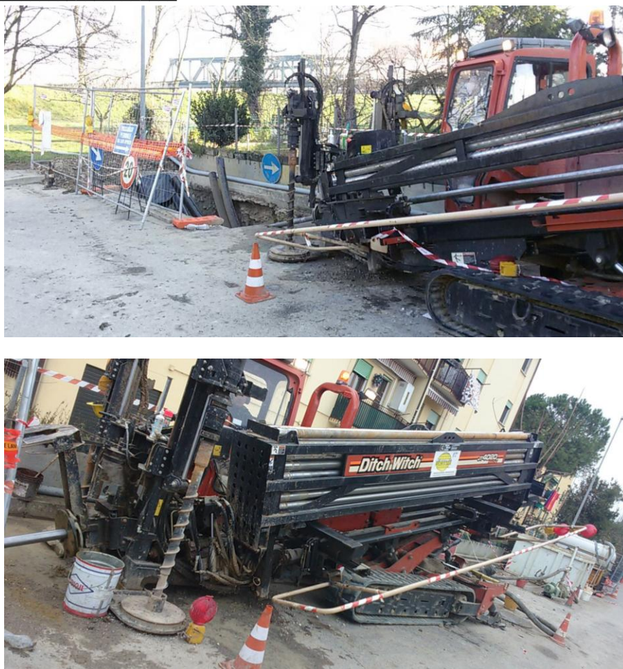
Foto 16 – immagini cantiere TOC. La trivellazione orizzontale controllata verrà eseguita a bordo strada con mezzi specifici (nella foto un cantiere per la posa di cavidotto stradale). Le piazzole di ingresso solitamente vengono realizzate in scavo al fine di indirizzare il punto di origine. Il cavidotto viene poi giuntato in un pozzetto con il tratto in arrivo e all'uscita della TOC con il tratto in partenza.
