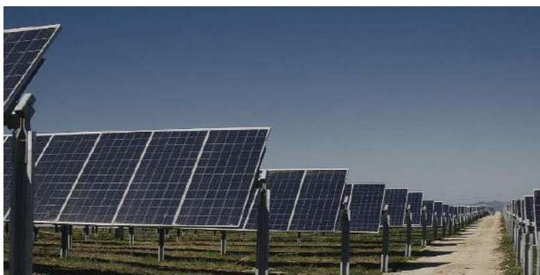
Figura 24: Immagine di un impianto con tracker 1P
