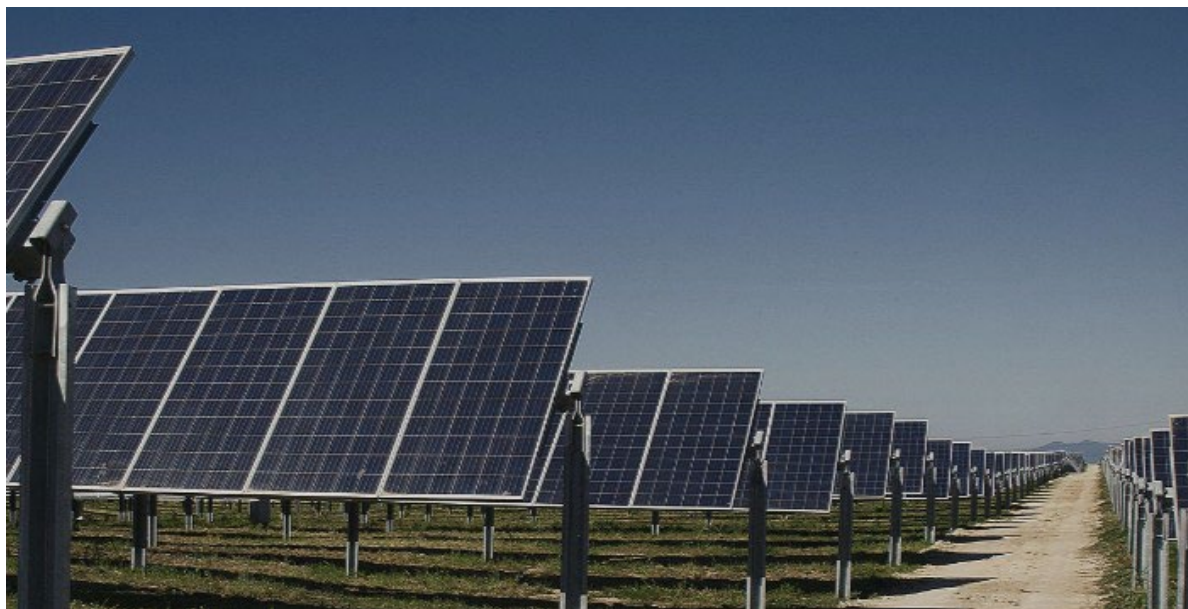
Figura 2 – Esempio di impianto fotovoltaico con tracker 1 P
