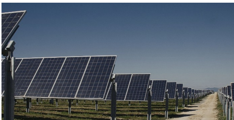
Figura 3: Immagine di un impianto con tracker 1P
