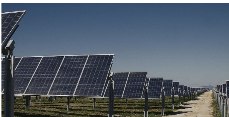
Figura 4: Immagine di un impianto con tracker 1P
