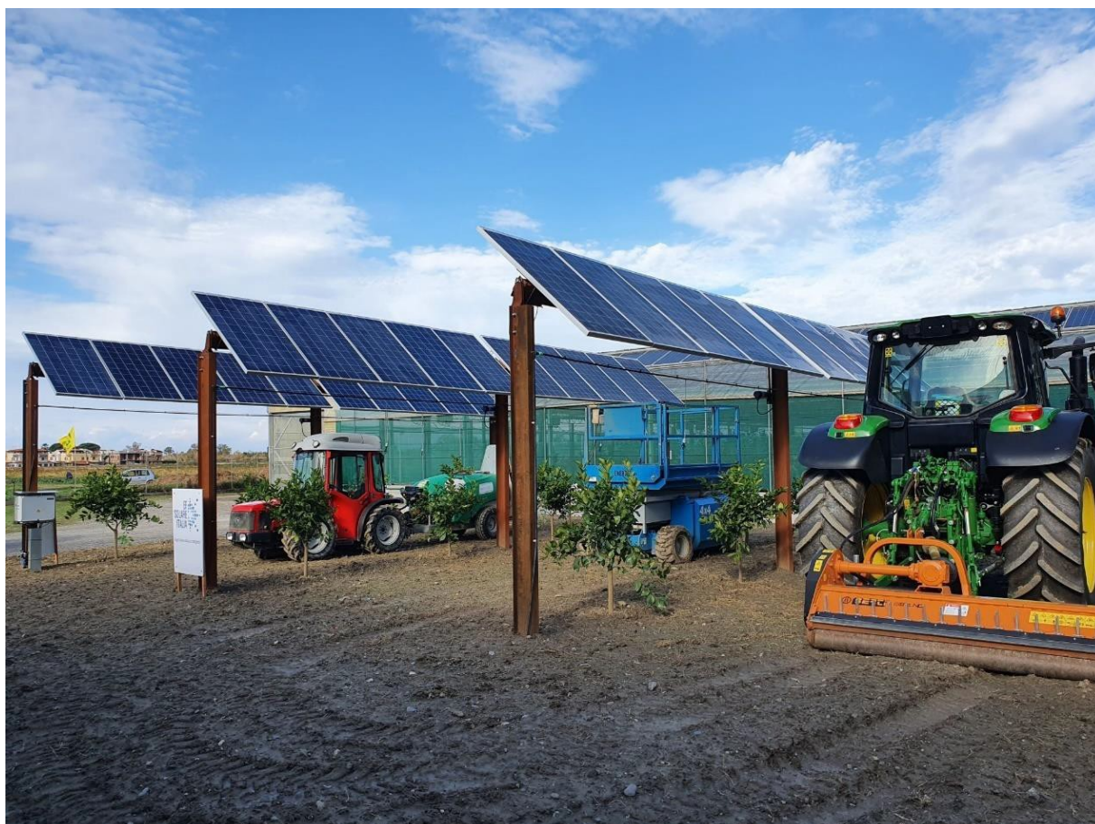
Figura 4 - Esempio di inseguitore monoassiale con integrazione agro-voltaica
