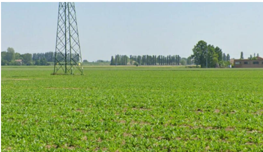
Figura C-54: Vista dell'impianto dal punto 44°33'22.95"N e 11°12'54.11"E verso Est.
