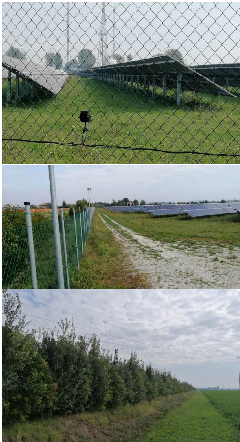
Figura 30 – Esempio di realizzazione di un impianto fotovoltaico senza fondazioni in cls e senza impermeabilizzazione del suolo, con schermatura perimetrale mediante siepi arbustive (scelte progettuali analoghe a quelle adottate per l'impianto in esame).
