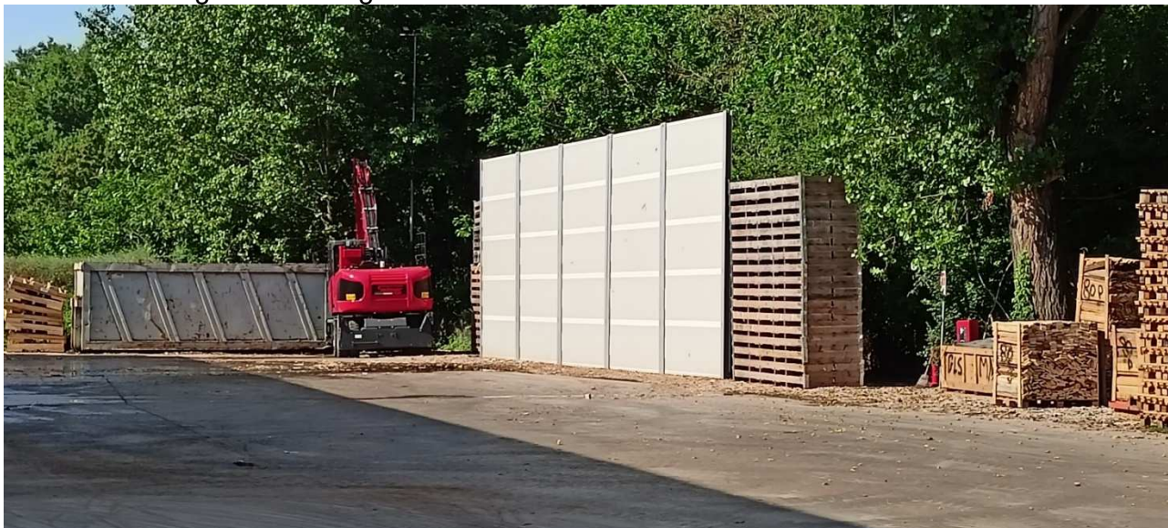
Figura 4 – fotografia della barriera fonoisolante e fonoassorbente
