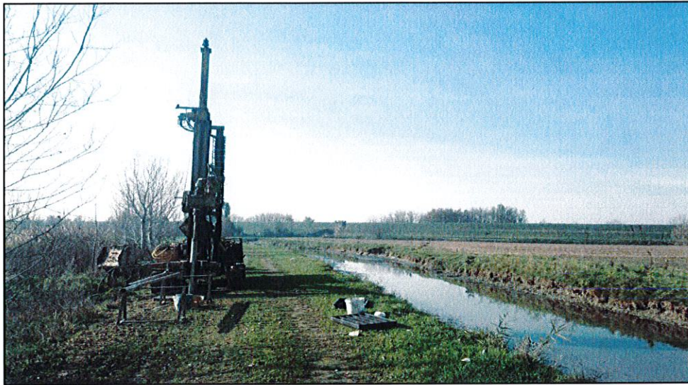
Ubicazione sondaggio - S2
