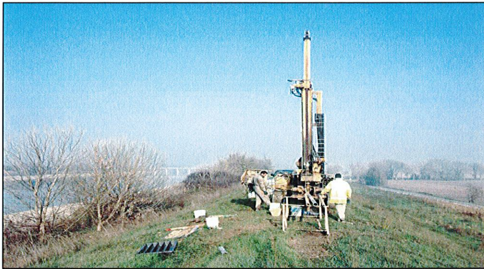
Ubicazione sondaggio - S1
