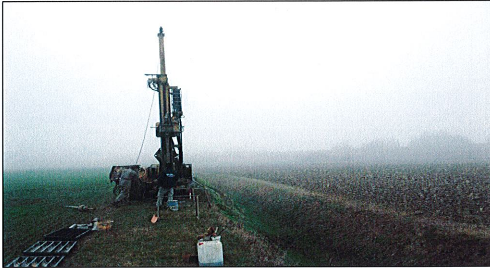
Ubicazione sondaggio - S4
