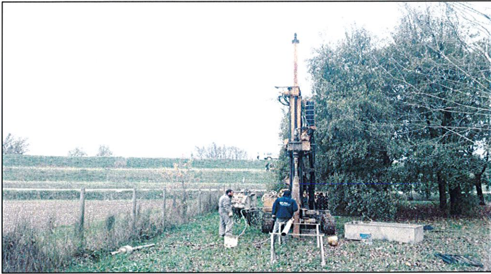
Ubicazione sondaggio - S3
