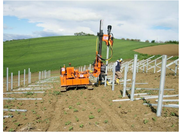
Figura 3 - Posa strutture metalliche di fondazione
