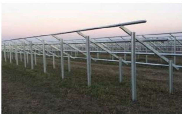
Figura 5-1 – Esempio di posa delle strutture portanti.
