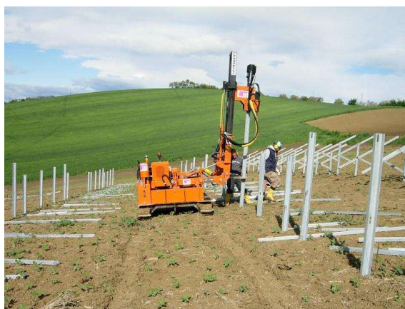
Figura 3: - Posa strutture metalliche di fondazione
