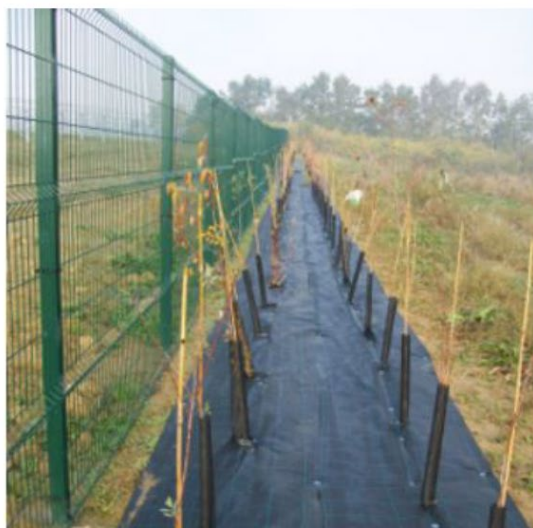
Messa a dimora delle piante su due file, con shelter e telo pacciamante
