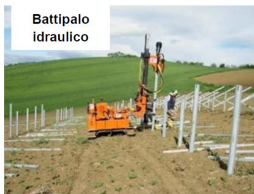
Figura 5-1 – Esempio di posa delle strutture portanti.
