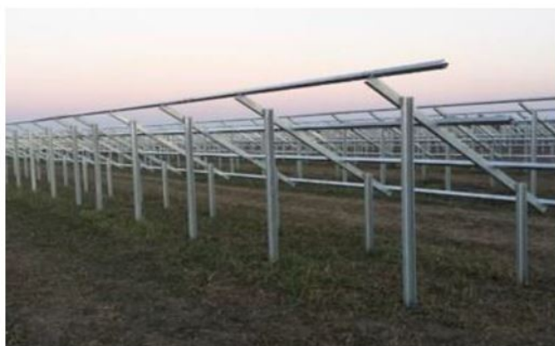
Figura 5-1 – Esempio di posa delle strutture portanti.
