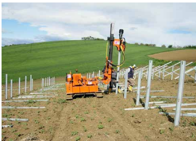
Figura 3-3 – Posa strutture metalliche di fondazione
