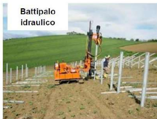
Figura 5-1 – Esempio di posa delle strutture portanti.
