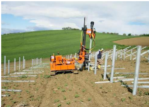
Figura 3-3 – Posa strutture metalliche di fondazione
