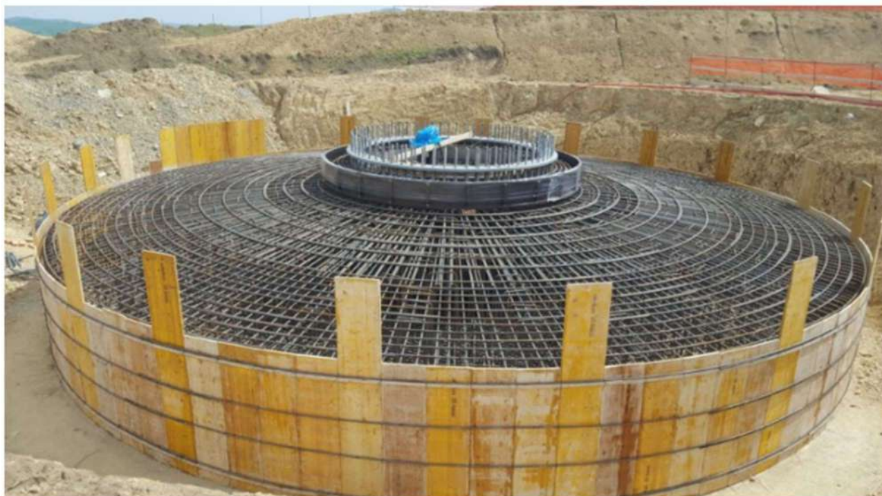
Figura 4 - Fondazione aerogeneratore
