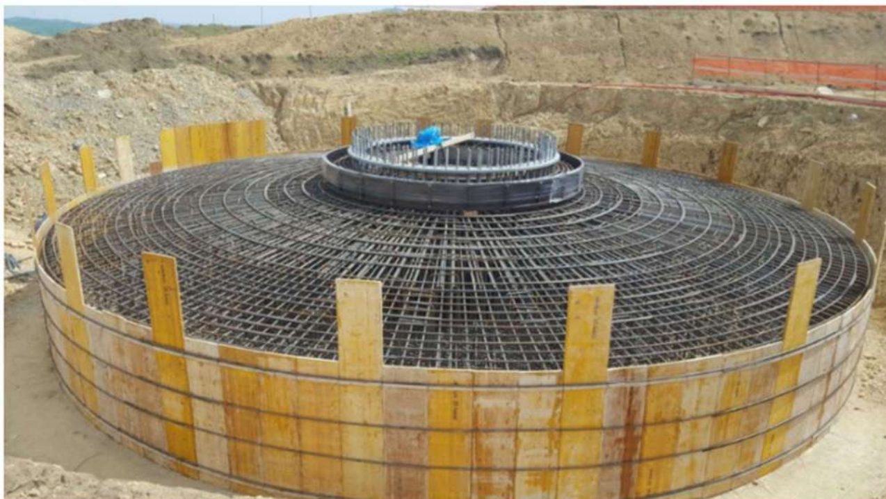
Figura 20 - Fondazione aerogeneratore
