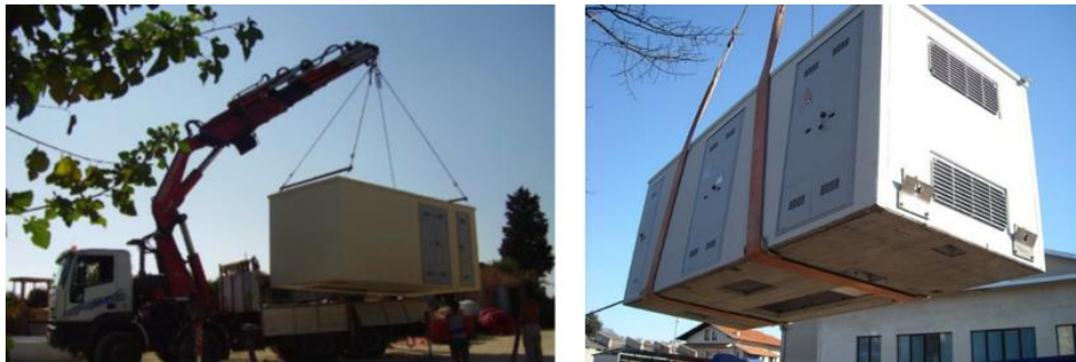
Figura 2: Fornitura e posa in opera dei locali tecnici
