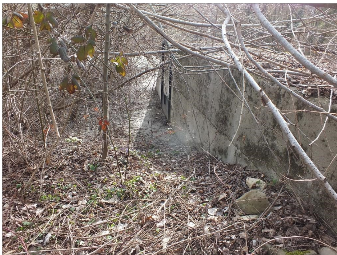
Figura 10 - Vista da monte della briglia, dalla spalla destra, dove è visibile la paratoia dell'opera di presa dismessa, che verrebbe utilizzata come sghiaiatore
