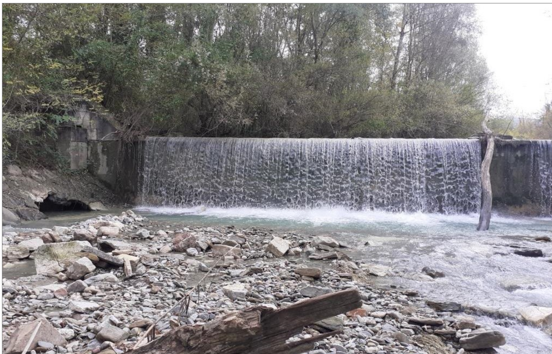
Figura 9 - Vista da valle della briglia su cui è proposta la nuova opera di presa
