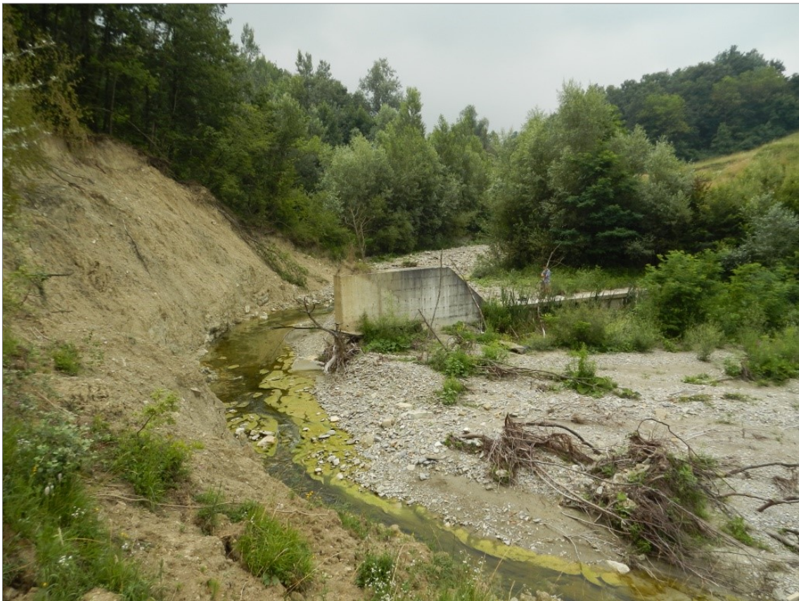
Figura 8 - Ripresa fotografica della briglia presso la quale era originariamente prevista l'opera di presa. Risultano evidenti i fenomeni di dissesto in sponda destra.
