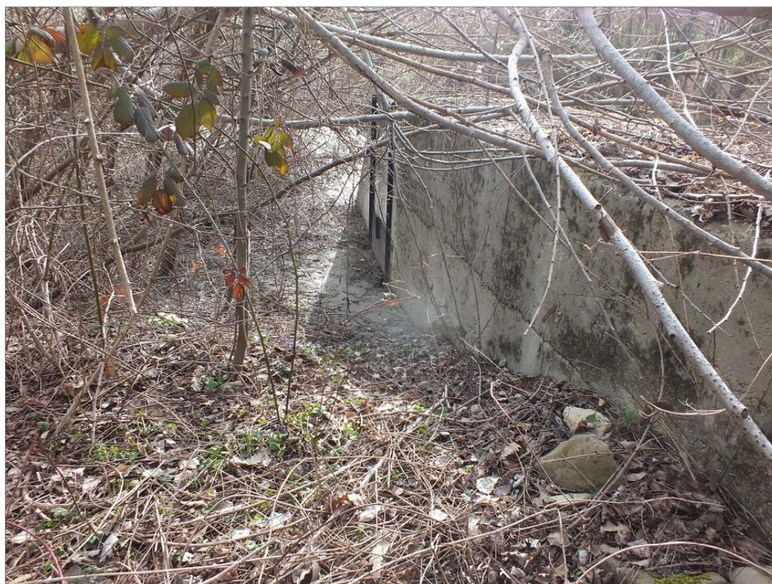
Figura 3 - Vista da monte della briglia, dalla spalla destra, dove è visibile la paratoia dell'opera di presa dismessa, che verrebbe utilizzata come sghiaiatore
