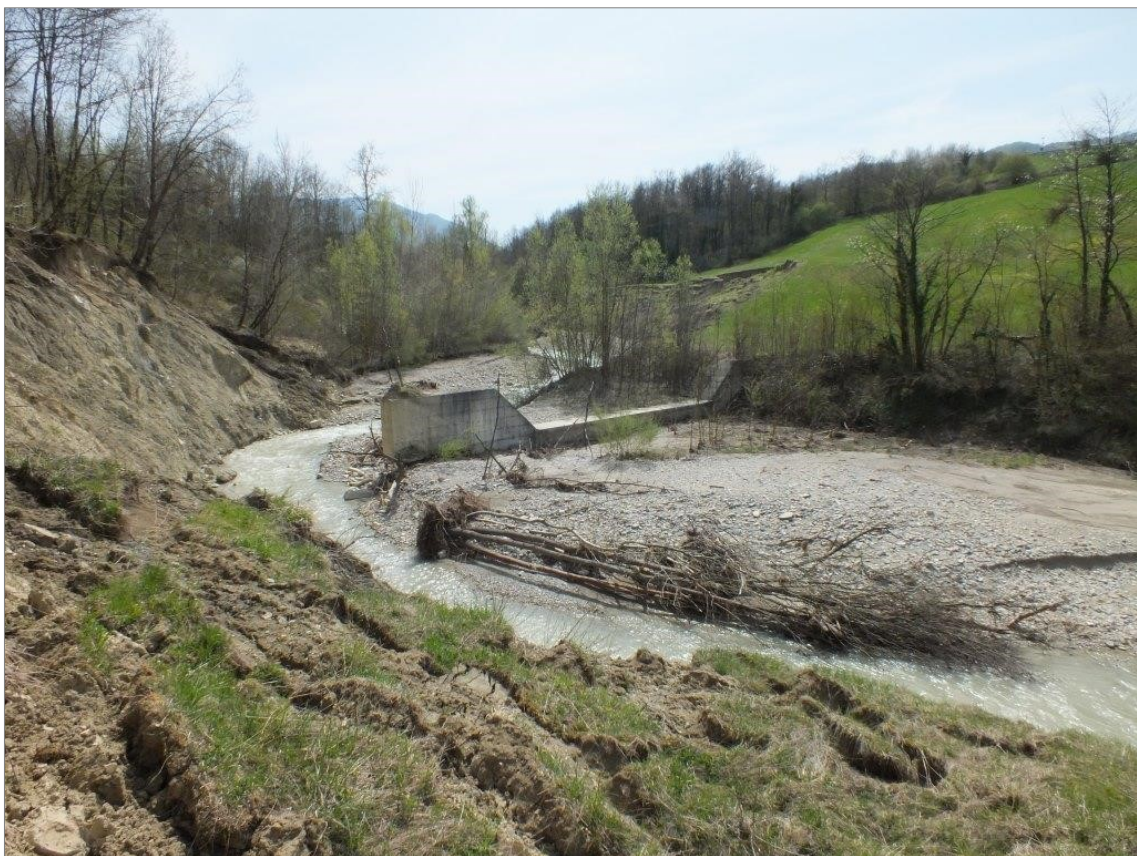
Figura 1 - Vista da valle della briglia su cui è autorizzata l'opera di presa. Sono evidenti in sponda destra (sinistra nell'immagine) i fenomeni di dissesto
