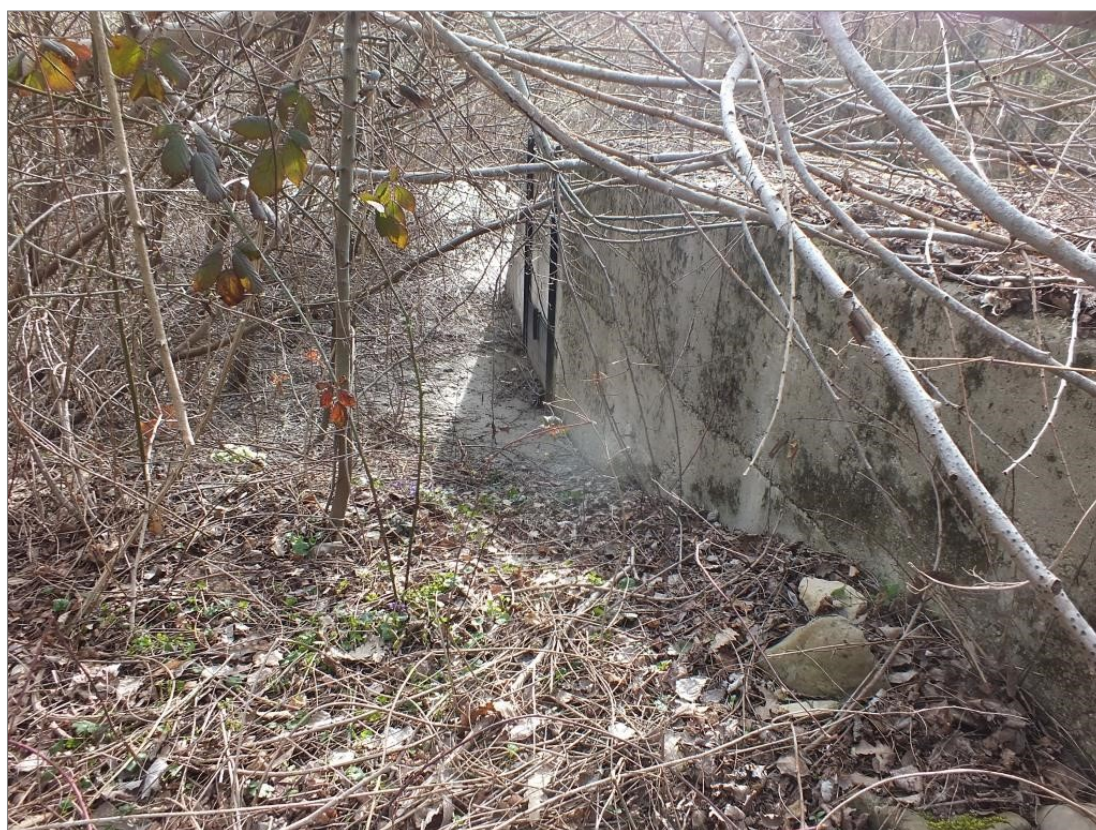
Figura 14 - Vista da monte della briglia, dalla spalla destra, dove è visibile la paratoia dell'opera di presa dismessa, che verrebbe utilizzata come sghiaiatore
