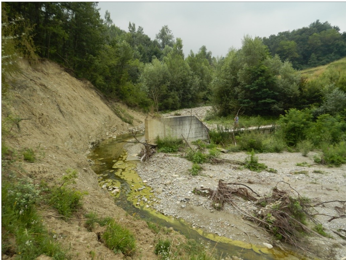
Figura 12 - Ripresa fotografica della briglia presso la quale era originariamente prevista l'opera di presa. Risultano evidenti i fenomeni di dissesto in sponda destra.
