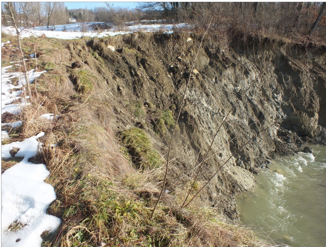
Figura 22 - Ripresa fotografica della sponda destra del Torrente Parmossa in corrispondenza della briglia aggirata dalla corrente
