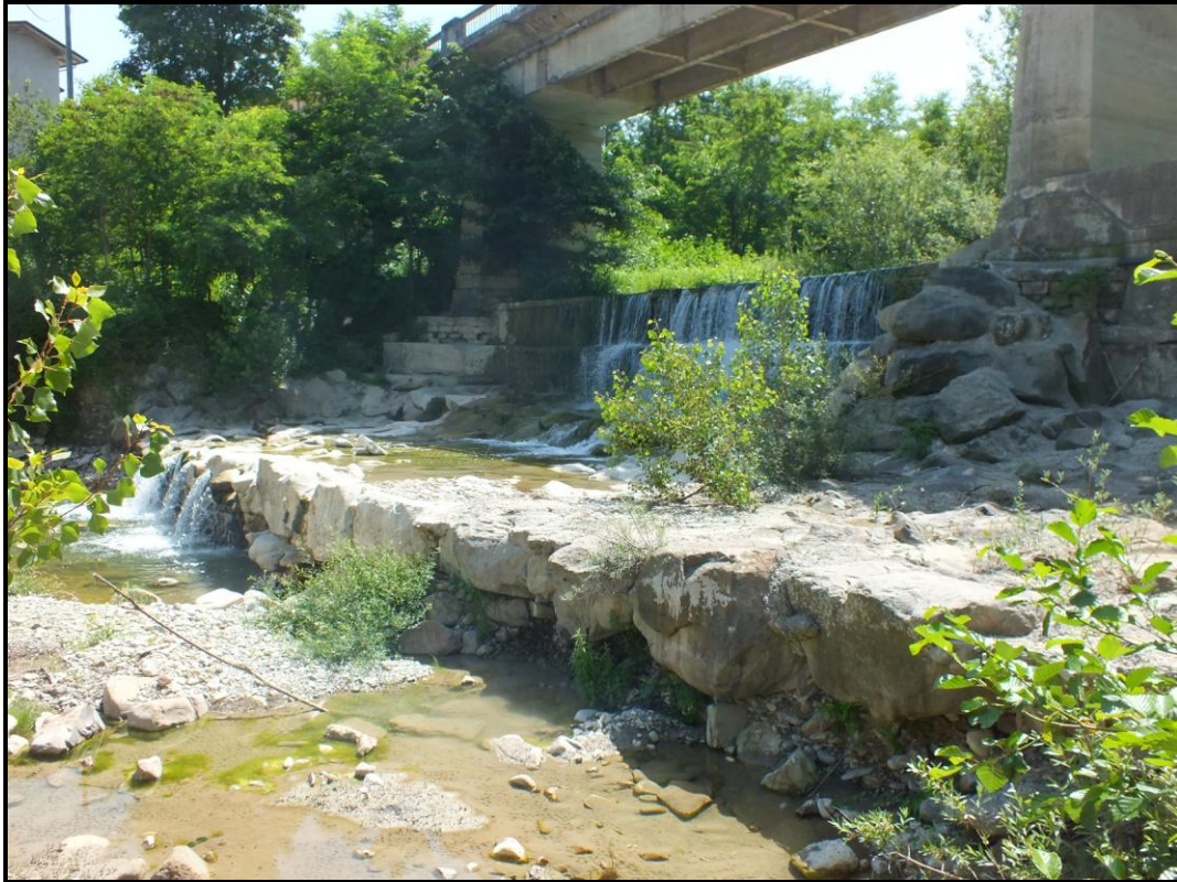
Figura 5: briglia insormontabile situata 600 m a valle del rilascio
