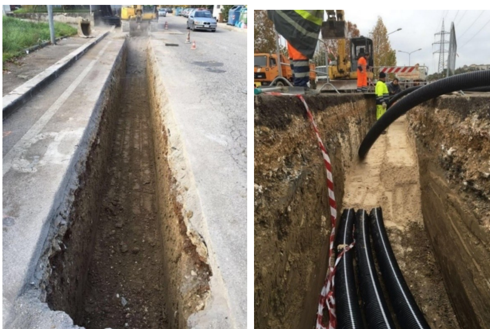
Figura 3 - Foto scavo trincea e foto di posa cavidotti
